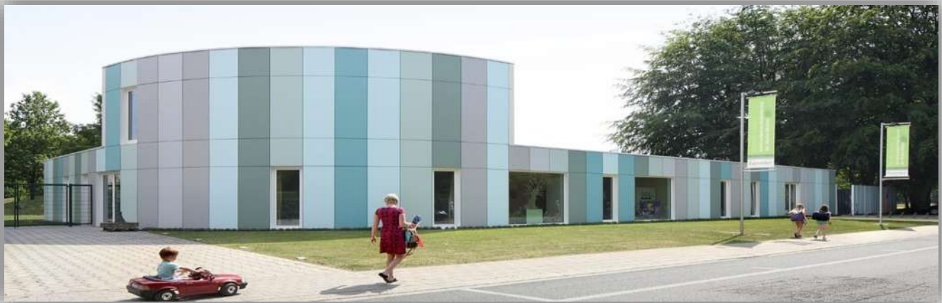
Foto 30. Fachada exterior de Guardería WE-S architecten ., [Fuente: ARCHDALY]
