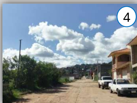
Foto 18. Calle Lauren, se encuentra pavimentada. [Fuente: L.G.A]
