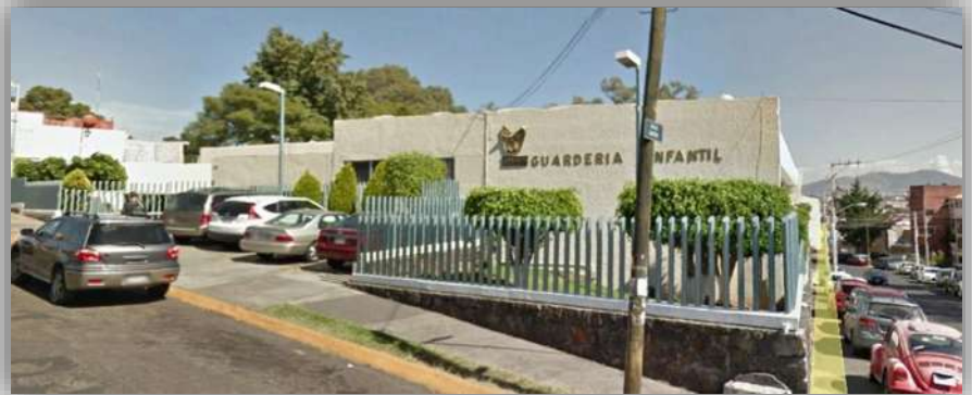
Foto 20. Fachada principal Guardería Infantil [IMSS]. [Fuente: L.G.A]
