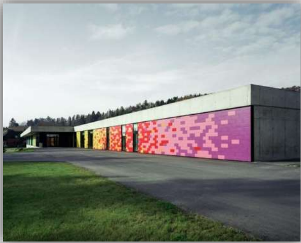
Foto 1. Fachada principal de la guardería KIBE, [Fuente: Krischner & Oberhofer photography]
