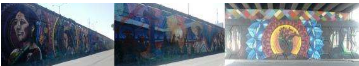
Imagen 4 El puente desnivel
