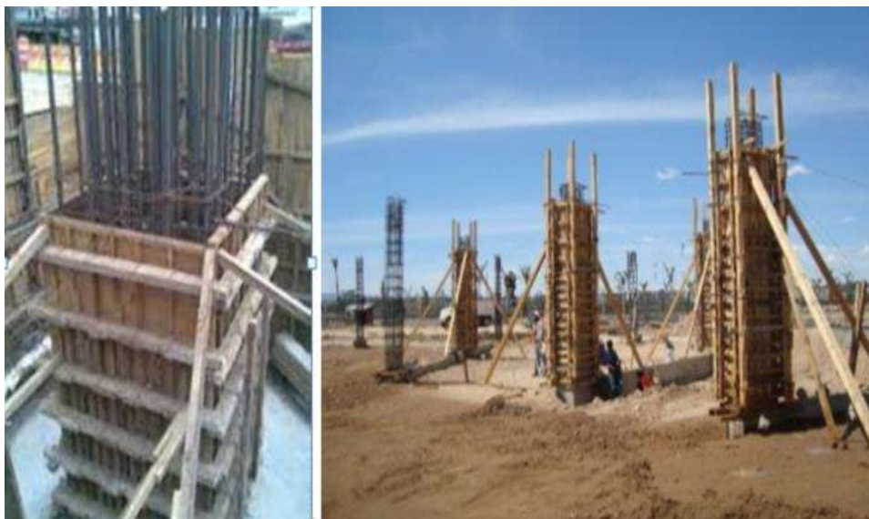
Imagen 31 Columna de concreto
