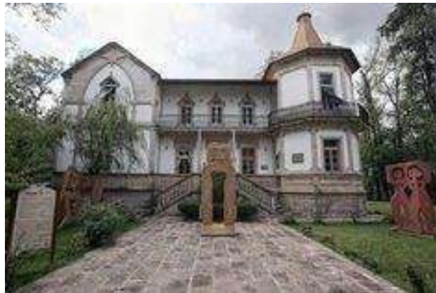
Imagen 27 fachada principal Del Museo De Arte Contemporánea “Alfredo Zalce”
