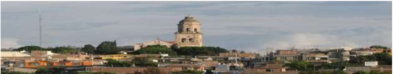
Figura No: 1.1 se observa una parte del municipio de Charo, Michoacán y su único templo, Fuente http://www.atiempo.mx/estado/en-charo-no-hay-problemas-de-violencia-raul-prieto/ [02/09/2016]
