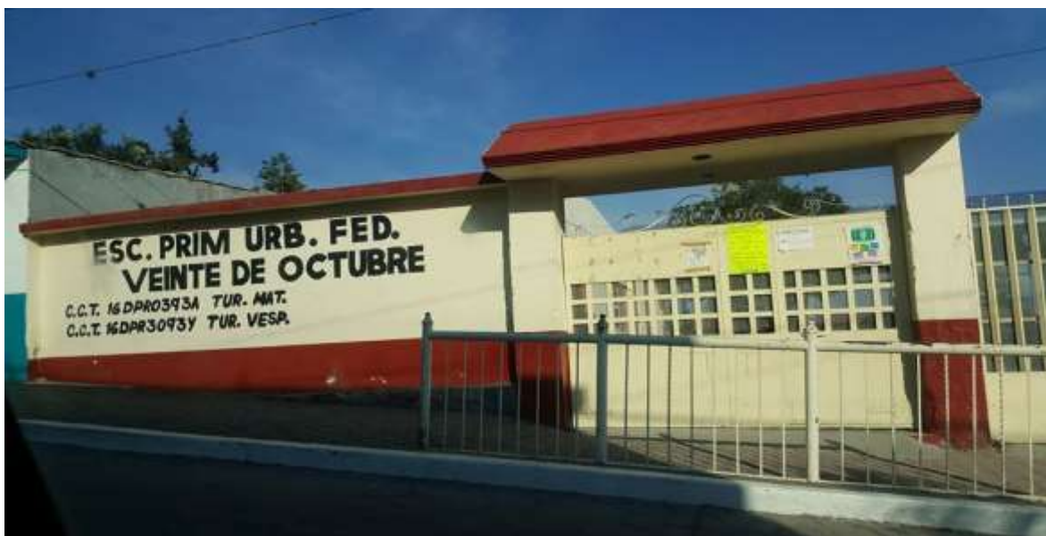
Figura número 4.1 se muestra la imagen de la primaria Veinte de octubre ubicada en la avenida veinte de octubre de la ciudad de Charo, Michoacán. Foto: Luis Fernando Meza Salazar [05/10/2016]
