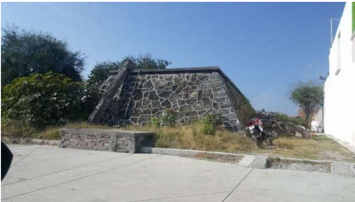
Figura número 4.8 en la imagen se muestra un tanque de agua potable Foto: Luis Fernando Meza Salazar [05/10/2016]
