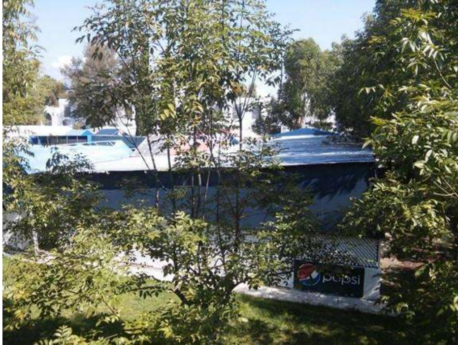
Foto 34 fachada sur, RAZ
