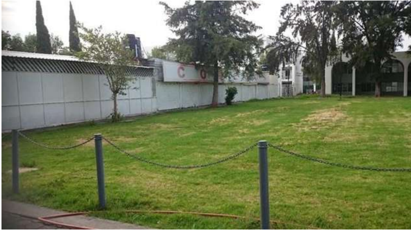
Foto 32 fachada oeste. RAZ
