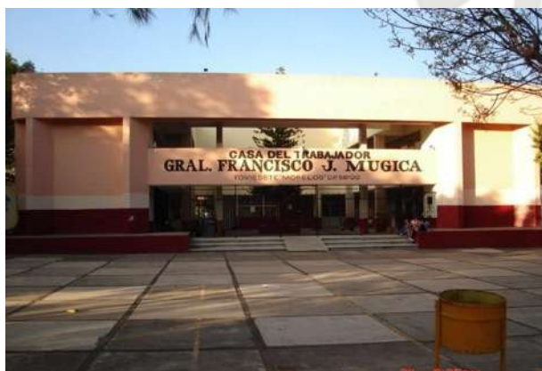
Fig. 4 Edificio de usos múltiples. 18 G.M.G.
