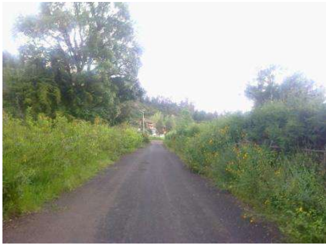
Imagen 67. dimencion y estado del acceso al predio indicado. Foto –Valdes –Arq. (2015) Archivo personal.
