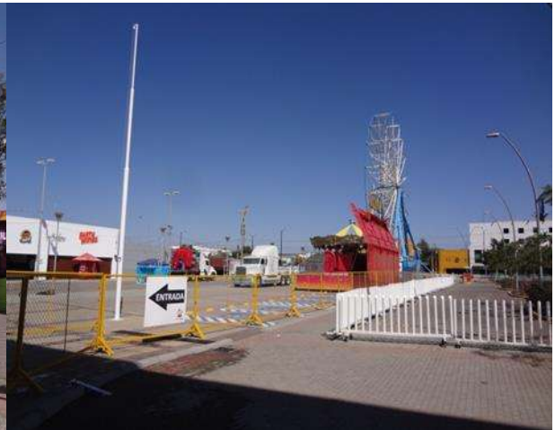
Imagen 38. Recinto Ferial de León. acceso lateral y Taquillas
