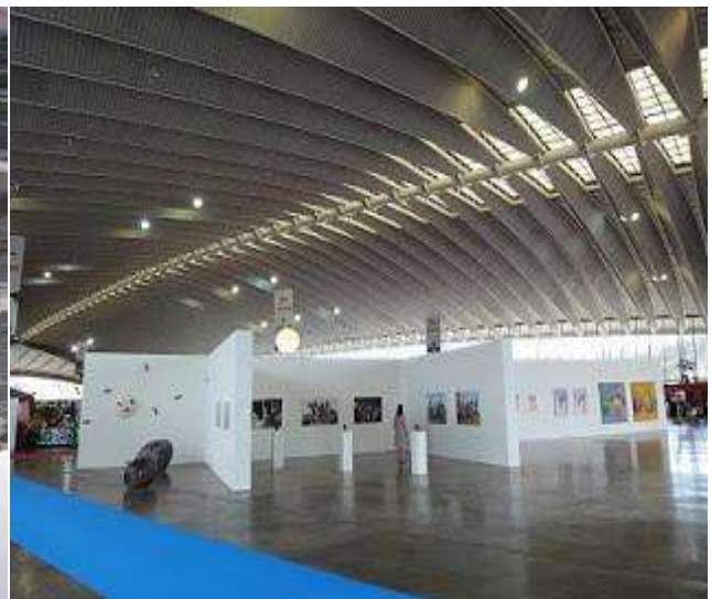
Imagen 34. Recinto Ferial de Tenerife (interior)
