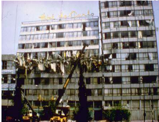
FUENTE: 57 (CENAPRED). (s.f.). Golpeo entre edificios. [Imagen]. Tomada del acervo fotográfico de la Subdirección de Riesgos Estructurales del
