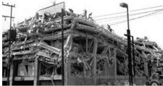
FUENTE: 52 Vulnerabilidad debida a una mala distribución de elementos resistentes [fotografía]. Tomada de Acervo de Fotografías y Figuras de la Subdirección de Riesgos Estructurales
