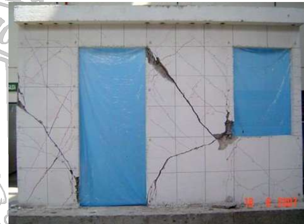
FUENTE: 32 (CENAPRED). (s.f.). Falla por tensión diagonal [fotografía].
