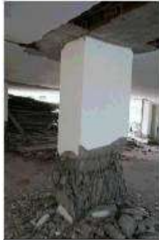
FUENTE: 23 Sismo de Turquía, 1999 Falla por compresión en columna con pandeo y ruptura de estribos [fotografías]. (1999). Tomadas de Dr. Sergio Alcocer Martínez de Castro, Turquía 1999.
