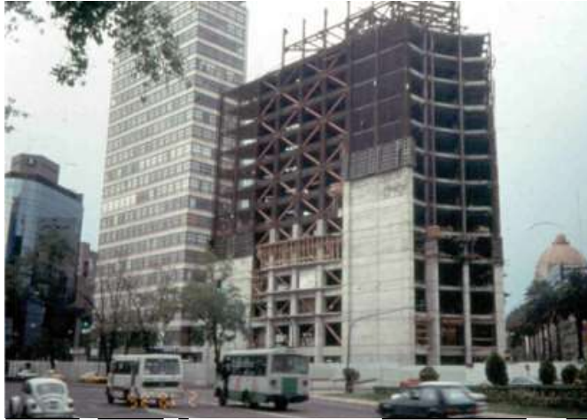
FUENTE: 13 (CENAPRED). (1997). Edificación [fotografía]. Tomadas de Acervo de fotografías y figuras de la Subdirección de Riesgos Estructurales del CENAPRED.
