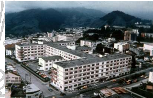
FUENTE: 49 (Organización Panamericana de la Salud). (2003). Mala configuración en planta [fotografía].
