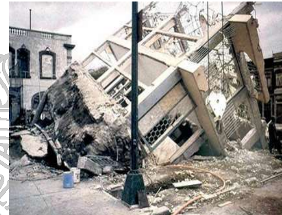
FUENTE: 46 (CENAPRED). (s.f.). Volteo de edificios (falla de cimentación) [fotografía].
