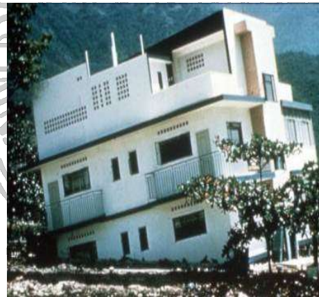
FUENTE: 47 (CENAPRED). (s.f.). Efecto de licuación de arenas. [Imágenes]. Tomadas de Acervo de Fotografías y Figuras de la Subdirección de Riesgos Estructurales del Cenapred.
