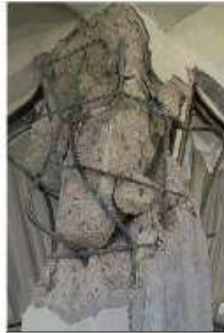
FUENTE: 23 Sismo de Turquía, 1999 Falla por compresión en columna con pandeo y ruptura de estribos [fotografías]. (1999). Tomadas de Dr. Sergio Alcocer Martínez de Castro, Turquía 1999.
