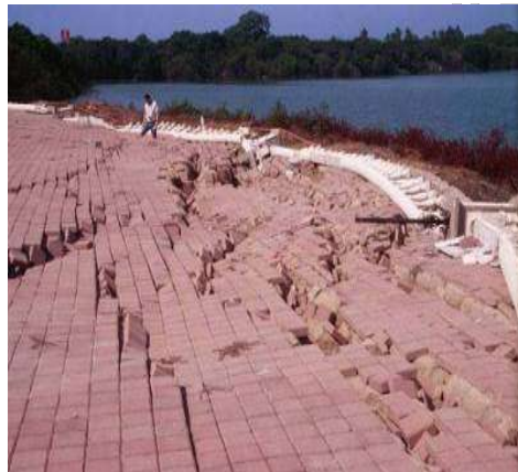
FUENTE: 47 (CENAPRED). (s.f.). Efecto de licuación de arenas. [Imágenes]. Tomadas de Acervo de Fotografías y Figuras de la Subdirección de Riesgos Estructurales del Cenapred.
