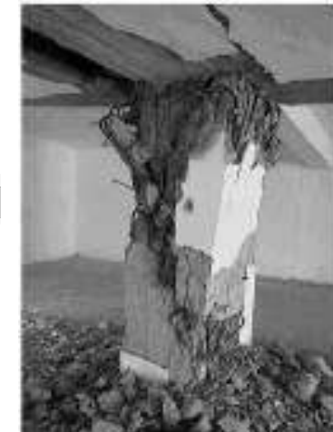
FUENTE: 24 Flexo-compresión en columna [fotografía]. (s.f.). Tomada de Dr. Sergio Alcocer Martínez de Castro, Turquía 1999.
