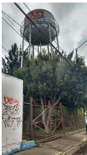
Ilustración 12 tanque elevado para abastecer de agua a la colonia de san Juanito itzicuaru foto: Erik Rafael López Hernández
