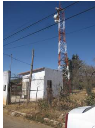
Imagen 31 Antena de Teléfonos de Mexico (TELMEX) en Zirahuén
