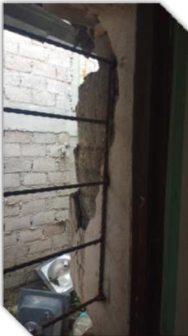
I. 012 Ventana sur Fuente: Tomada por el Autor
