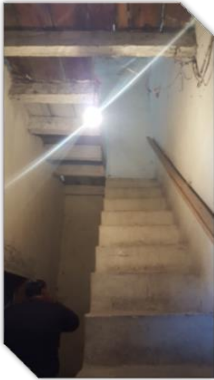
I. 007 Escaleras Fuente: Tomada por el Autor
