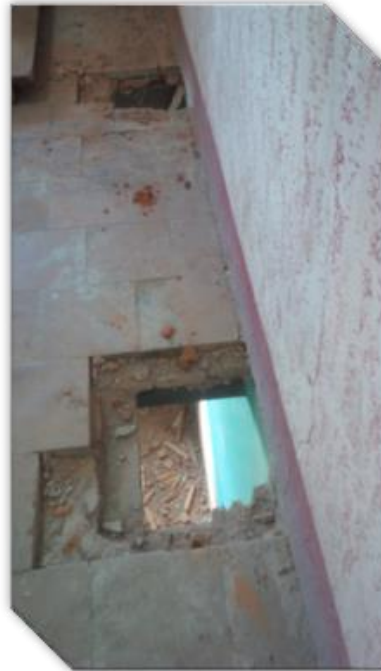
I. 011 Entrepiso Fuente: Tomada por el Autor
