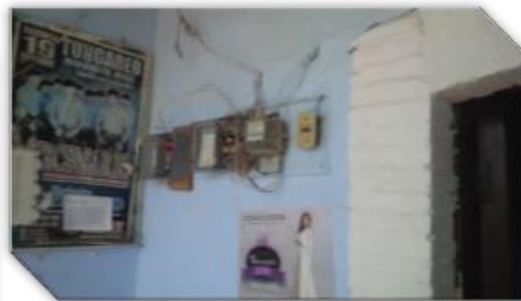
I. 006 Espacio oficinas, Fuente: Tomada por el Autor
