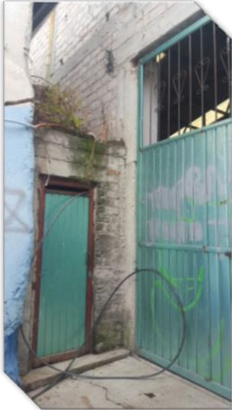
I. 003 Sur del inmueble, Fuente: Tomada por el Autor
