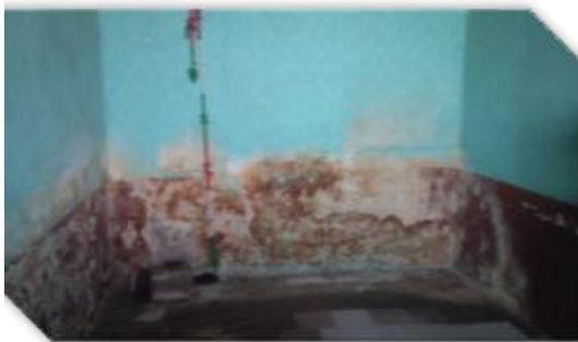
I. 005 Espacio oficinas, Fuente: Tomada por el Autor
