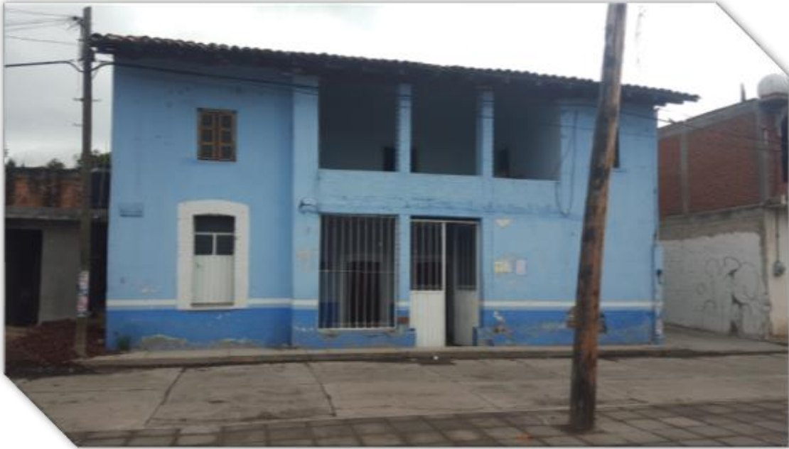
I. 001 Fachada Principal, Fuente: Tomada por el Autor
