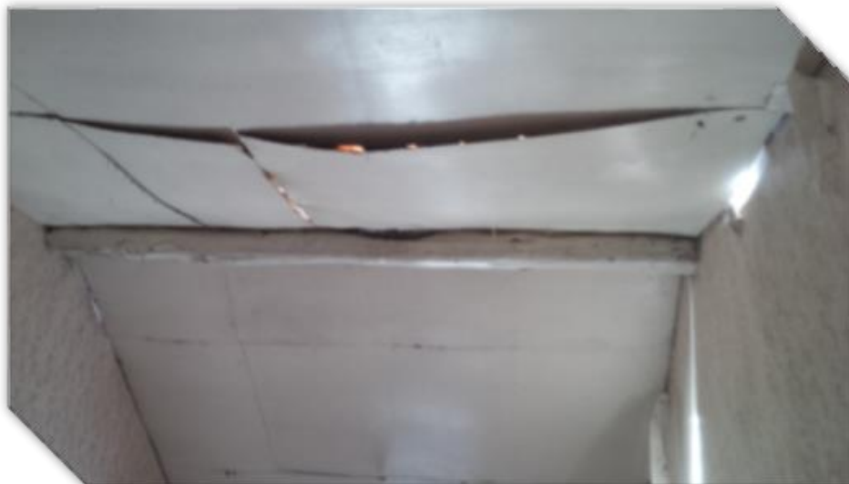
I. 009 Oficina principal Fuente: Tomada por el Autor
