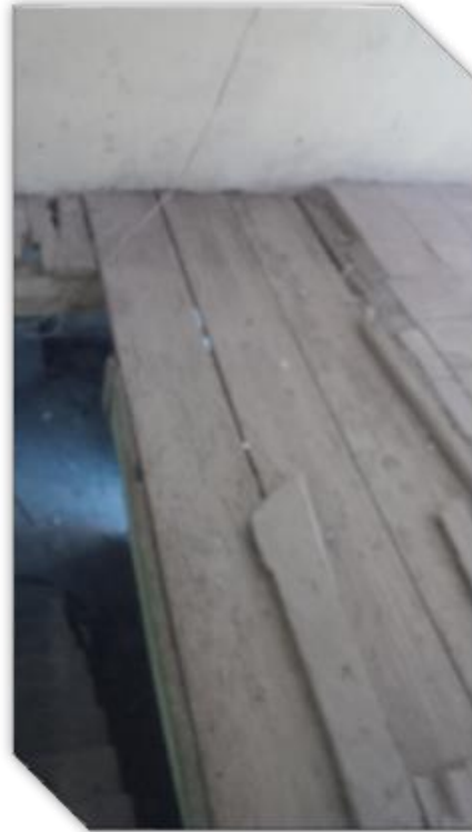
I. 008 Escaleras Fuente: Tomada por el Autor
