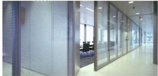
Fig. 48 Muro de Vidrio Templado. Fuente: http://vidriotemplado-reflecta.blogspot.mx/
