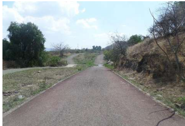
Fig.32 Tramo de Trota pista a las faldas del Cerro del Quinceo. Foto: Landy Janeth Zárate Martínez Fecha: diciembre 2017
