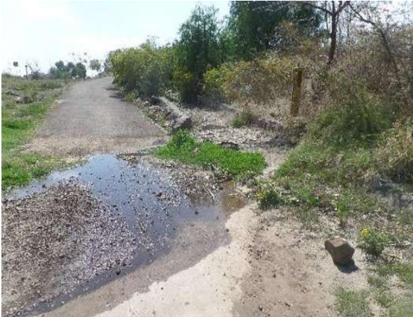
Fig.54 Tramo de la Ciclo pista cortado a consecuencia de un escurrimiento natural. Ubicado en a las Faldas del Quinceo.
