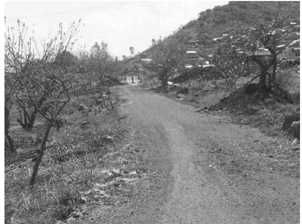
Fig.53 Deslaves de la trota pista, tramo ubicado en una de las colonias sin asignación de nombre.
