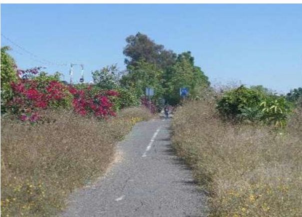
Fig.68 Tramo de Ciclo pista del Parque Lineal Bicentenario, sin luminarias. Foto: Landy Janeth Zárate Martínez
