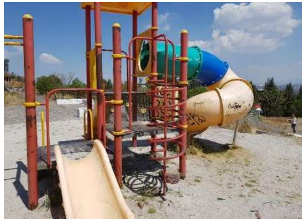
Fig.71 Juegos infantiles de una de las áreas del Parque Lineal Bicentenario, con presencia de vandalismo, deterioro y destrucción. Ubicado a espaldas del Estadio Morelos. Foto: Landy Janeth Zárate Martínez. Fecha: febrero 2018
