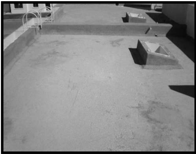
Figura 21 En este caso es una azotea nueva, donde se tiene que revisar pendientes, bajadas y grietas. << Imagen tomada por JFR 2012>> Consultado el 13.12.2017
