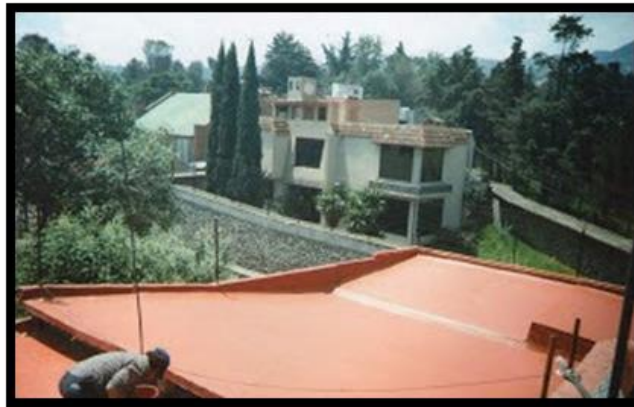
Fig.4 Cubierta sistema de viguería de madera.
