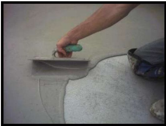
Fig.12 Aplicación de impermeabilizante cementoso con llana. << http://www.albaniles.org/albanileria/como-aplicar-cemento-elastico-para-impermeabilizar-terrazas-y-techos/ >> Consultada el 28.12.2017.
