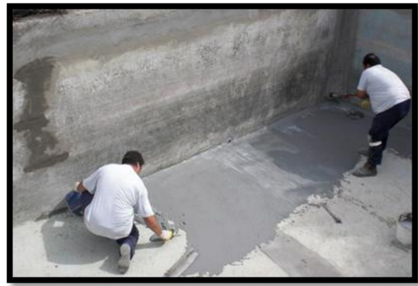
Fig.13 Aplicación de impermeabilizante cementoso con cepillo. << https://www.impermeabilizantes.com.mx/galeria/ >> Consultada 28.12 .2017.
