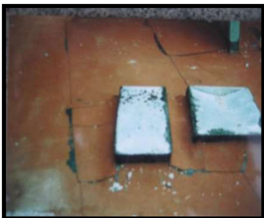
Figura 35 Reacción del impermeabilizante cuando no son compatibles. <Tomada por JFR>. Consultada 20.12.2017
