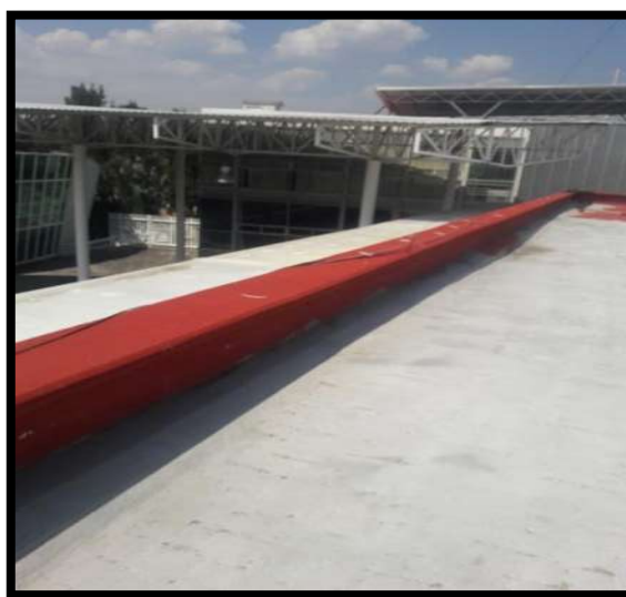
Figura. 33 Pretil de azotea<Tomada JFR>. Consultada el 01.01.2018
