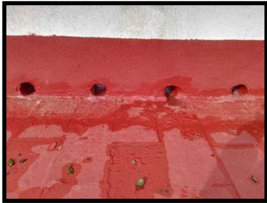
Figura 34 Reacción del impermeabilizante cuando no son compatibles. <Tomada por JFR>. Consultada 20.12.2017
