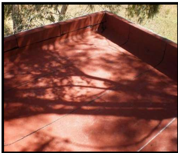
Figura 37 Impermeabilización con mano de obra calificada. <Tomada por JFR>. Consultada el 12.12.2017
