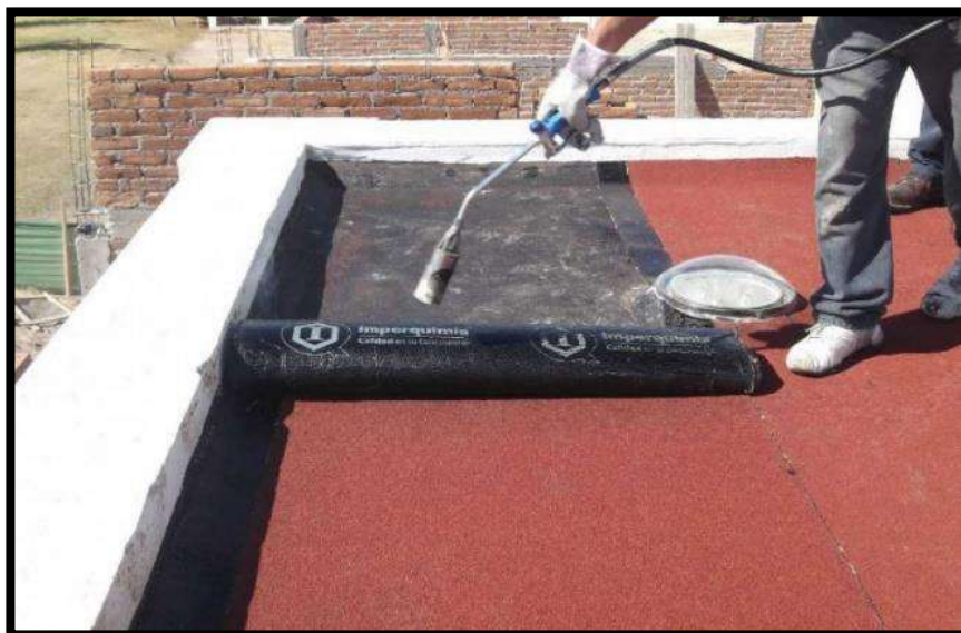
Fig.17 Aplicación del lienzo por medio de termofusión con soplete. < http://construfix.mx/blog/impermeabilizacion-con-prefabricados-para-industria/ >. Consultada el 28.12.2017
