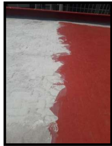
Figura 34 Reacción del impermeabilizante cuando no son compatibles. <Tomada por JFR>. Consultada 20.12.2017
