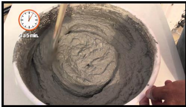
Fig.14 mezcla del impermeabilizante cementoso << http://www.dimatech.com.ar/ser_membranageotextil.php >> Consultada el 28.12.2017
