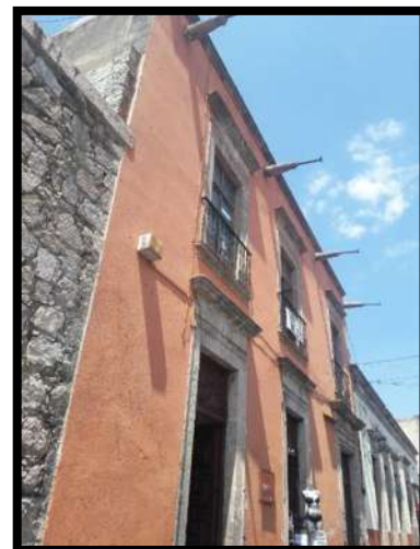
Fig.5 Vista gárgolas localizadas en perímetro del techo.
