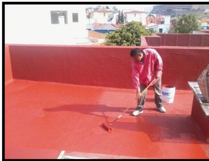
Fig.8 Impermeabilización acrílica; Aplicación de impermeabilizante en frío. <<://fotos.habitissimo.com.mx/foto/impermeabilizacion-en-acrilico_45965>> Consultado el 13.12.2017.
