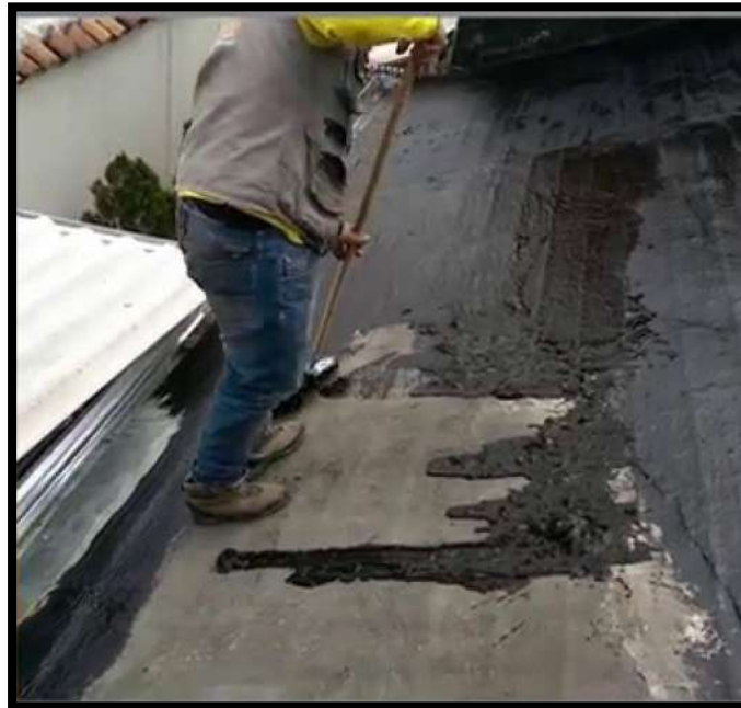
Fig.7 Impermeabilización asfáltica en frío; Este Impermeabilizante es emulsionado en frío; Este impermeabilizante es emulsionado en frío << Tomadas en Morelia en 1995 por JFR>>
