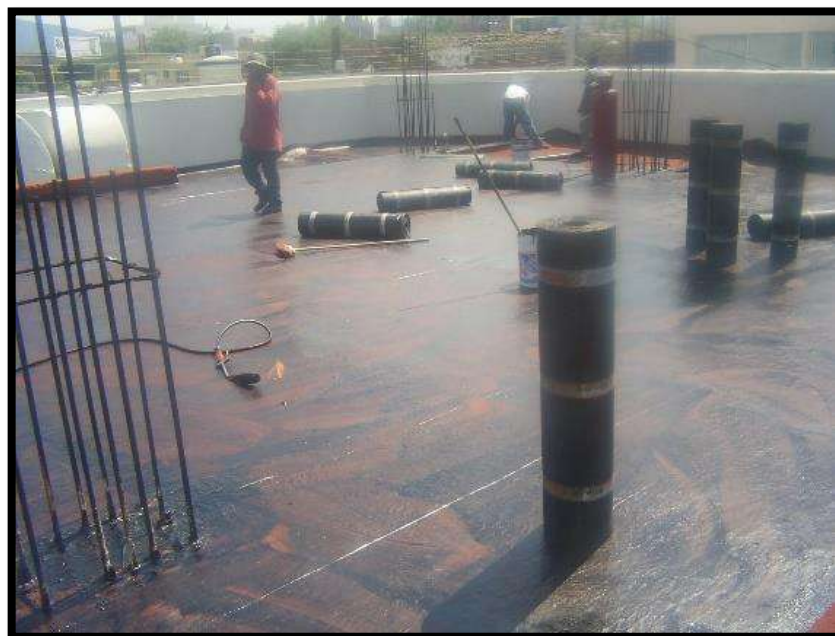
Fig.18 Azotea óptima para la colocación del impermeabilizante prefabricado. << Tomada por JFR>> Consultada el 28.12.2017
