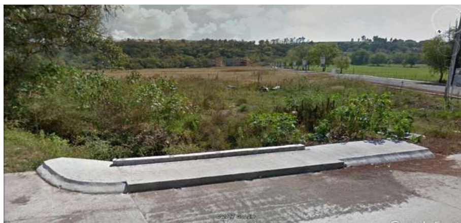
Imagen 38 – Fachada oeste del terreno. Tomada por el autor
