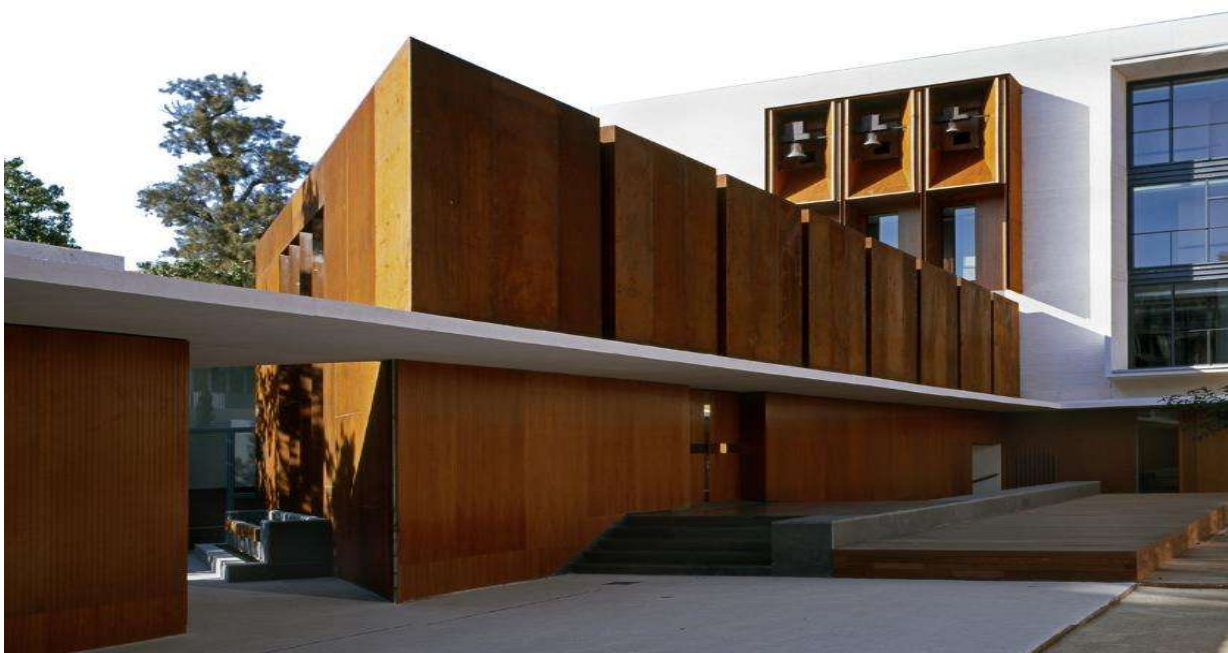
Imagen 29. - FACHADA. "Residencia Tercera Edad y Capilla San José" (Valencia, Spain).
