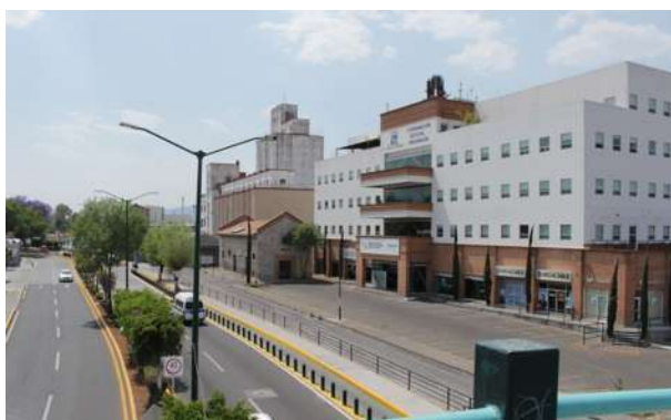
Imagen. 36 Oficinas sobre ave. Héroes de Nocupétaro Se observa sobre la avenida uno de los espacios recuperados en la zona para la construcción de oficinas gubernamentales. Autora
