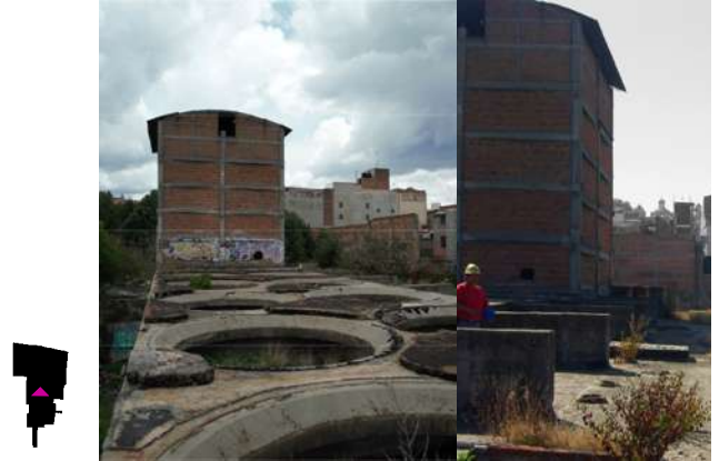
Imagen. 39 Construcción remanente Autora
