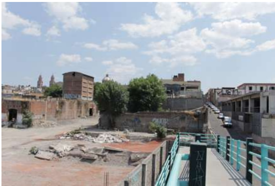
Imagen. 24 Localización del terreno A la derecha se observa el terreno seleccionado y a la izquierda la calle Valentín Gómez Farías. Autora
