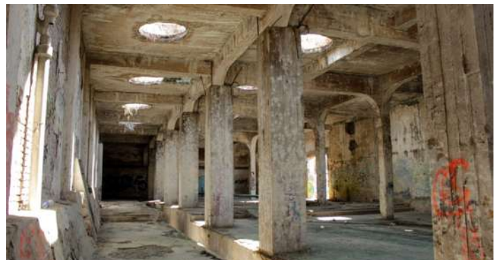
Imagen 31 Interior de la edificación vertical principal. Autora
