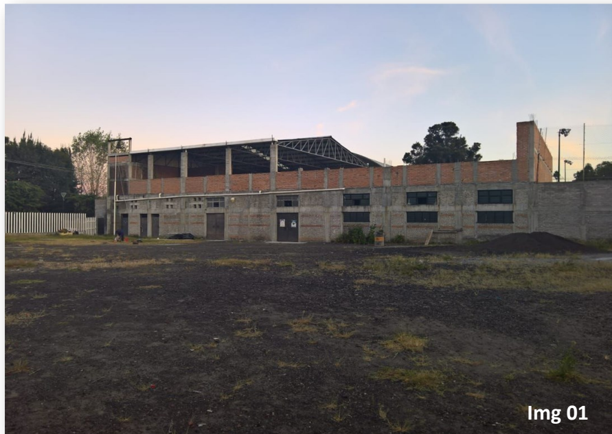
Img 01. Fachada del estado actual del inmueble. Fotografía Monserrat Lemus, noviembre 2018
