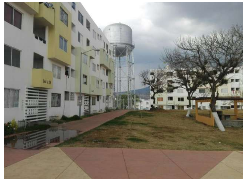
Imagen 91: andadores peatonales que comunican al área común equipada con las viviendas. Se puede observar que en el andador poniente se presentan encharcamientos. Fuente: Autor. Fecha de captura: 25/febrero/2018.
