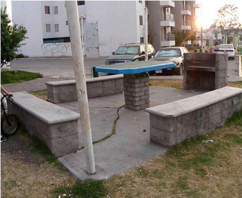
Imagen 62: detalle de quiosco oeste, donde se puede observar que se encuentra en mejores condiciones respecto del ubicado al norte, a excepción del piso con cuarteaduras. Fecha de captura: 03/marzo/2018.
