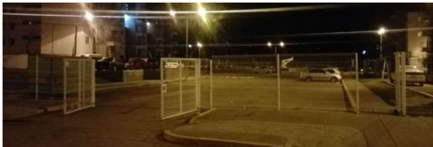
Imagen 29: acceso a estacionamiento 3, las puertas peatonales y vehiculares se encuentran abiertas. Fuente: Autor. Fecha de captura: 05/marzo/2018, 4:00 am.
