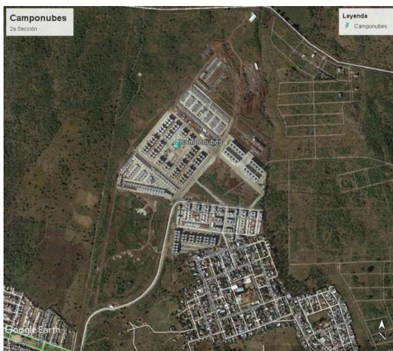
Imagen 74: Conjunto habitacional Camponubes; imagen obtenida de Google Earth de fecha 26/feb/18
