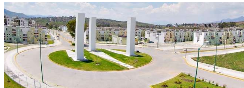
Imagen 13: Vista hacia el sur del desarrollo, en la glorieta ubicada en la Intersección entre la Avenida Rodolfo González Hurtado y Avenida Alonso Martínez Serrano.- imagen obtenida del sitio http://www.casasherso.mx/index.php/fraccionamientos/michoacan/morelia/villas-oriente . Fecha de consulta: 20/enero/2018.
