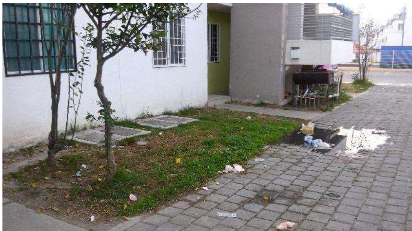
Imagen 35: presencia de basura y encharcamientos en los espacios destinados a la circulación peatonal al sur de J4. Fuente: Autor. Fecha de captura 12/febrero/2018.
