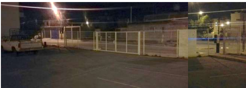
Imagen 30: acceso a estacionamiento 4, las puertas peatonales encuentran abiertas, mientras que la vehicular está cerrada. Fuente: Autor. Fecha de captura: 05/marzo/2018, 4:00 am.
