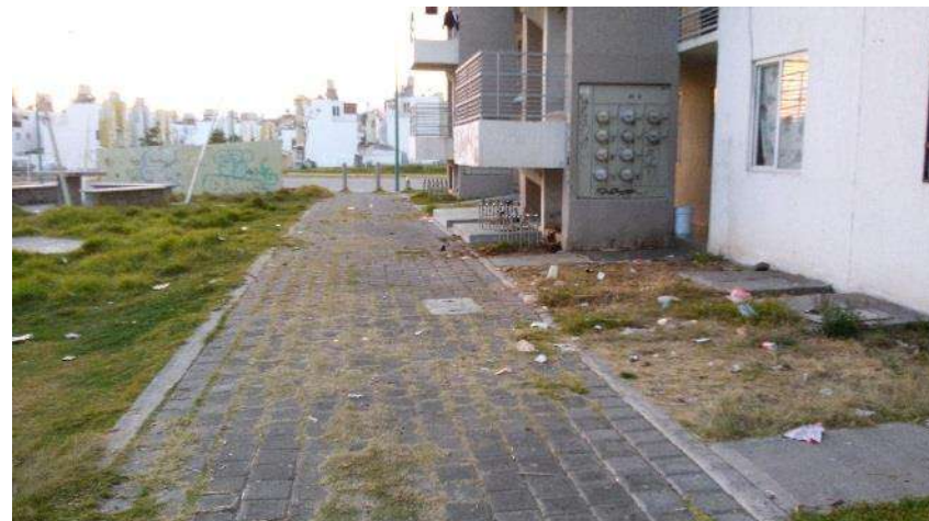
Imagen 37: presencia de basura en los espacios destinados a la circulación peatonal. Fuente: Autor. Fecha de captura 12/febrero/2018.
