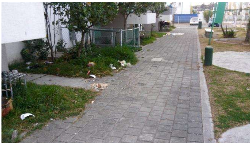
Imagen 36: presencia de basura y encharcamientos en los espacios destinados a la circulación peatonal al sur de J4. Fuente: Autor. Fecha de captura 12/febrero/2018.
