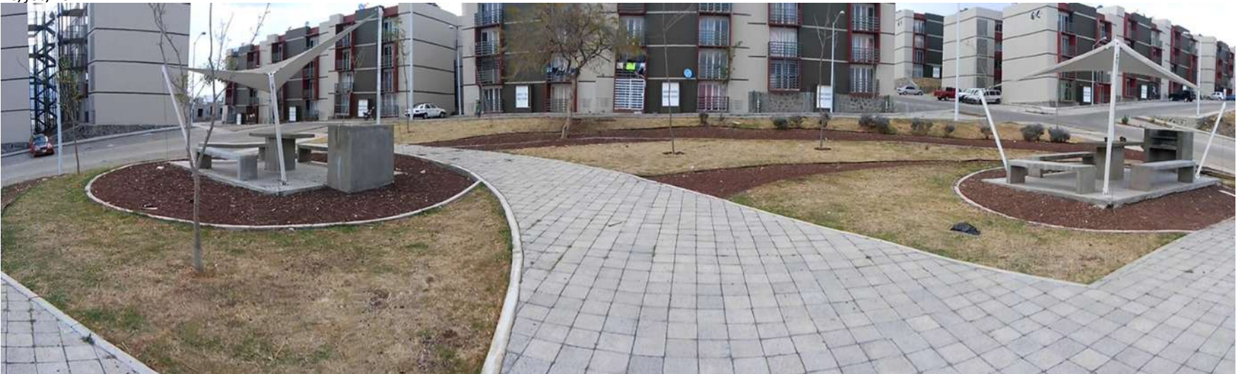
Imagen 83: detalle de la terraza 1, donde se encuentran los quioscos. Aquí se pueden observar los andadores de tezontle y los de adoquín, los cuales siguen un trazo orgánico; de manera general, la zona se encuentra en buenas condiciones. Fuente: Autor. Fecha de captura: 30/marzo/2018.
