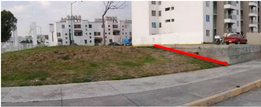
Imagen 41: visto sur de J1, donde se puede apreciar que donde el nivel de piso desciende desde el del estacionamiento, la construcción del andador se vio interrumpida; para darle continuidad sería necesaria la construcción de una escalinata. Fuente: Autor. Fecha de captura 03/marzo/2018
