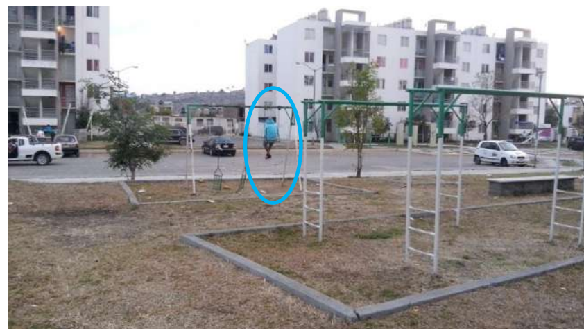
Imagen 53: dado a que al mobiliario urbano le hacen falta reparaciones, los residentes lo utilizan de la manera que les sea posible. Fuente: Autor. Fecha de captura: 03/marzo/2018.
