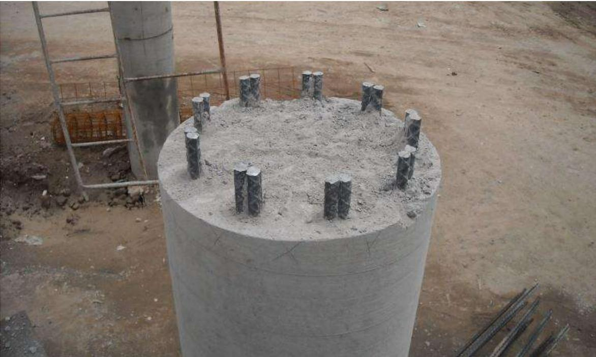
*Fig. 38. Columnas de concreto armado.
