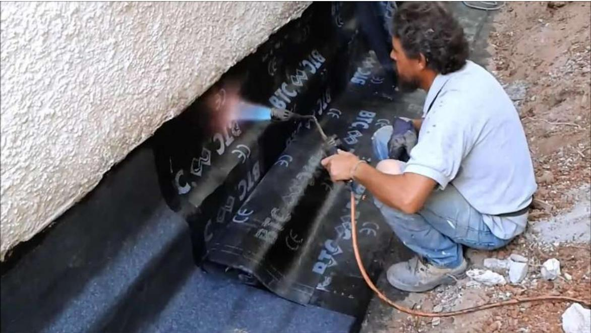
*Fig. 17. Impermeabilización de la cimentación.
