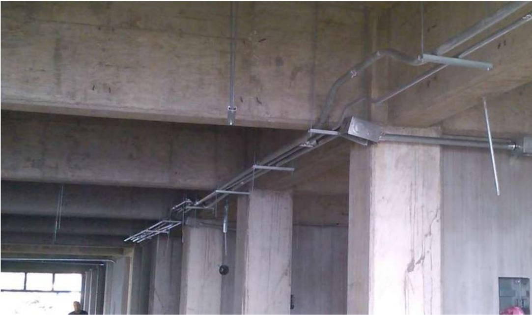
*Fig. 141. Colocación de tubería conduit. Fuente: José Luis Chávez Calderón (2016).*
