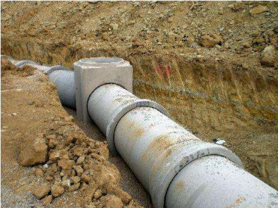
*Fig. 53. Construcción de registros.
