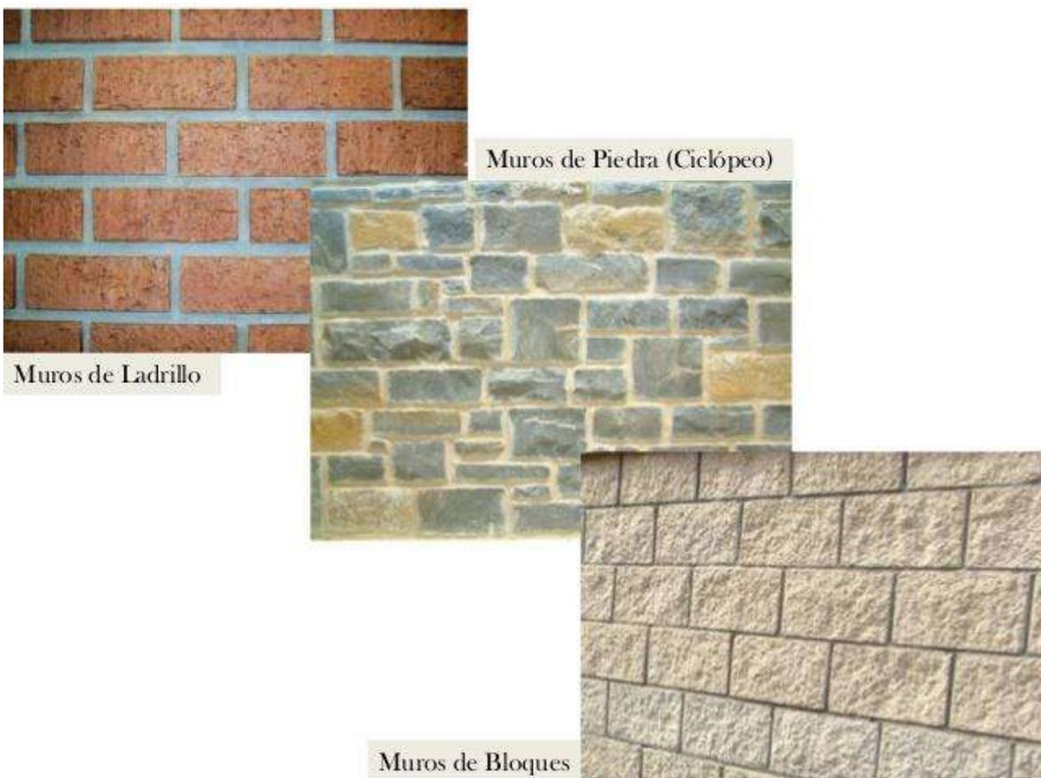
*Fig. 36. Distintos tipos de muros.*
