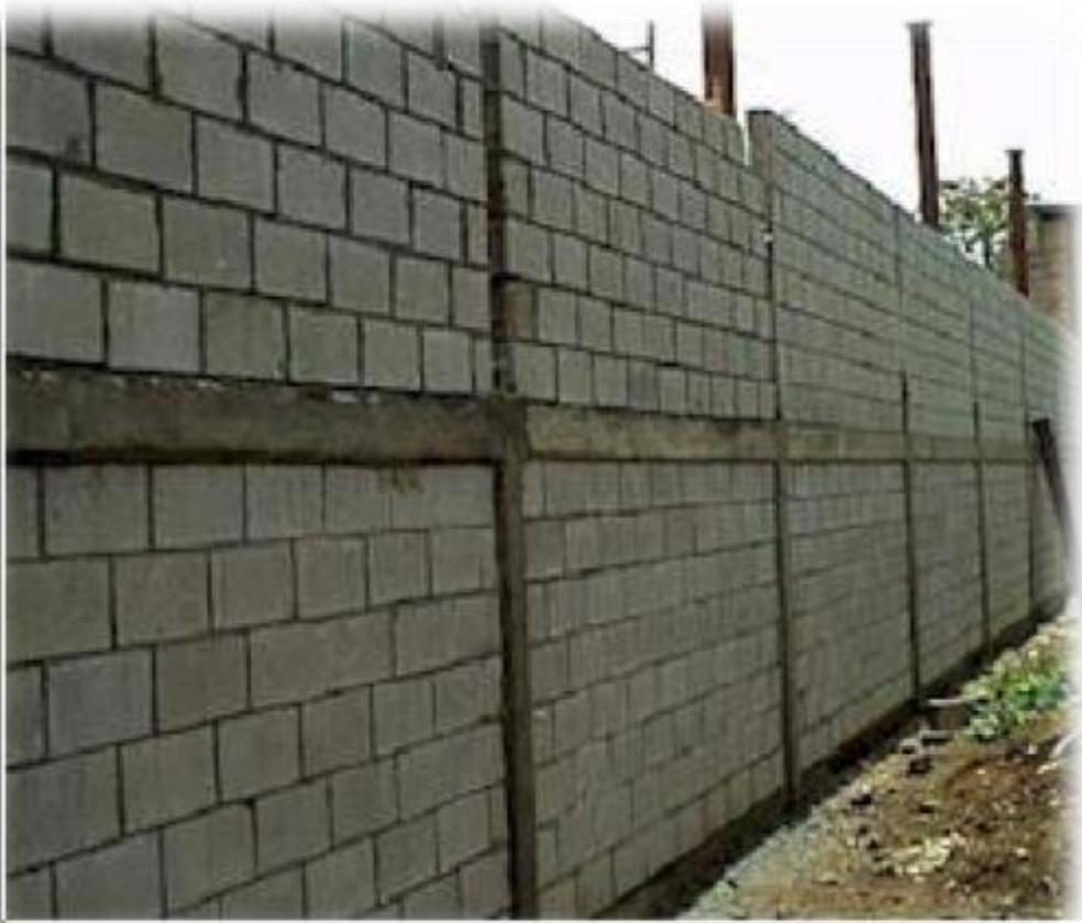
*Fig. 35. Muros de block de cemento.*
