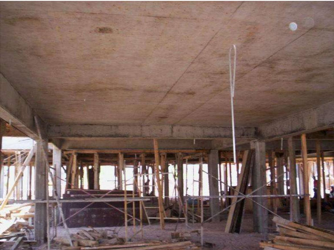
*Fig. 19. Descimbrado de obra.*
