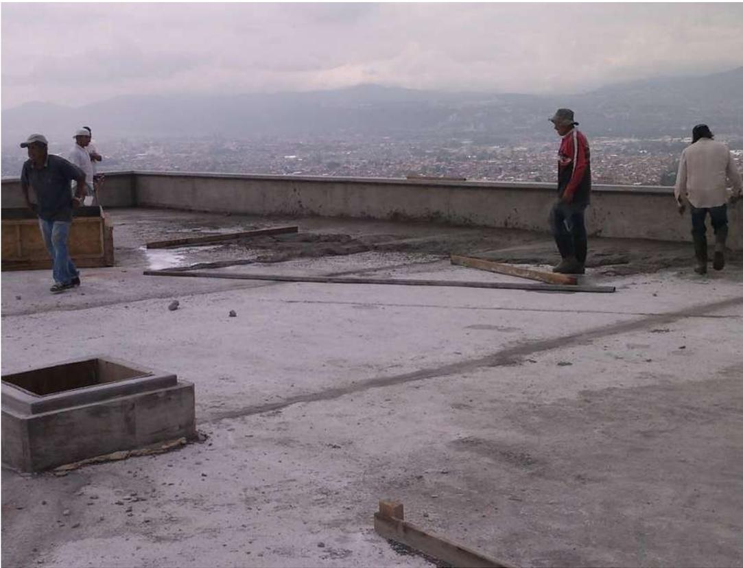
*Fig. 139. Colocación de colocación de entortado a base de mortero cemento y arena. Fuente: José Luis Chávez Calderón (2016).*
