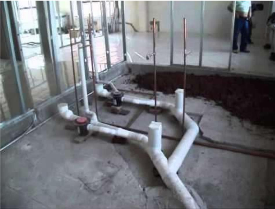
*Fig. 49. Instalación sanitaria.*
