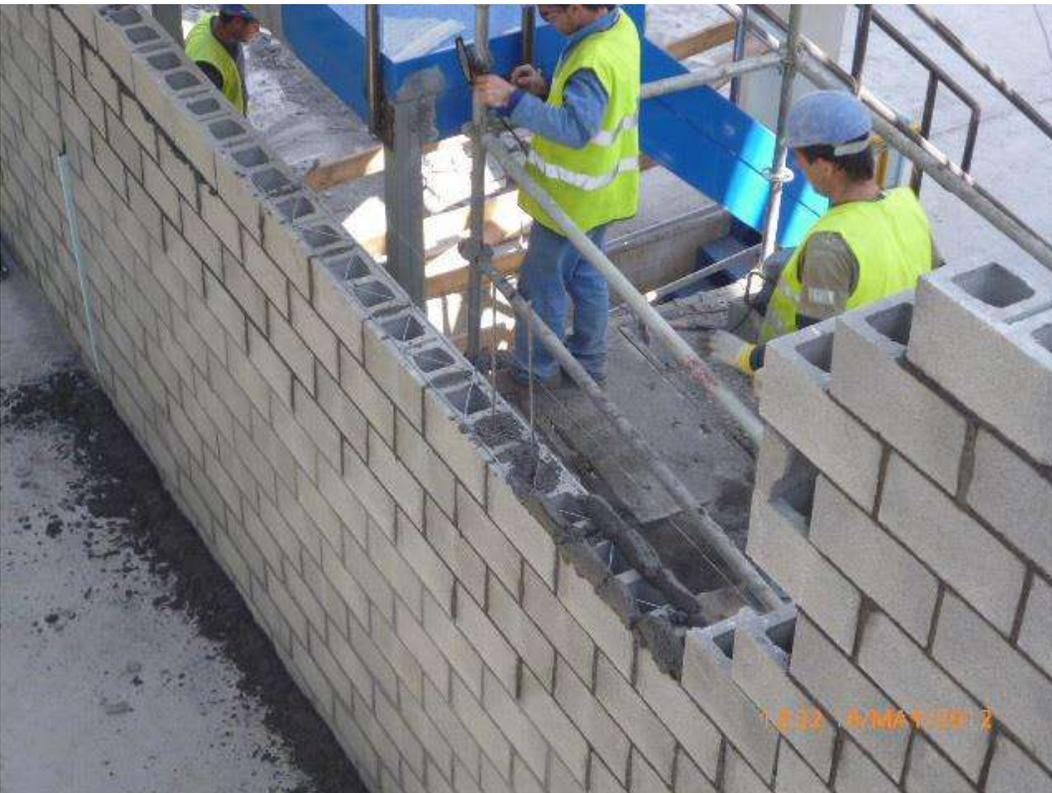
*Fig. 37. Celosía de bloques de cemento.*
