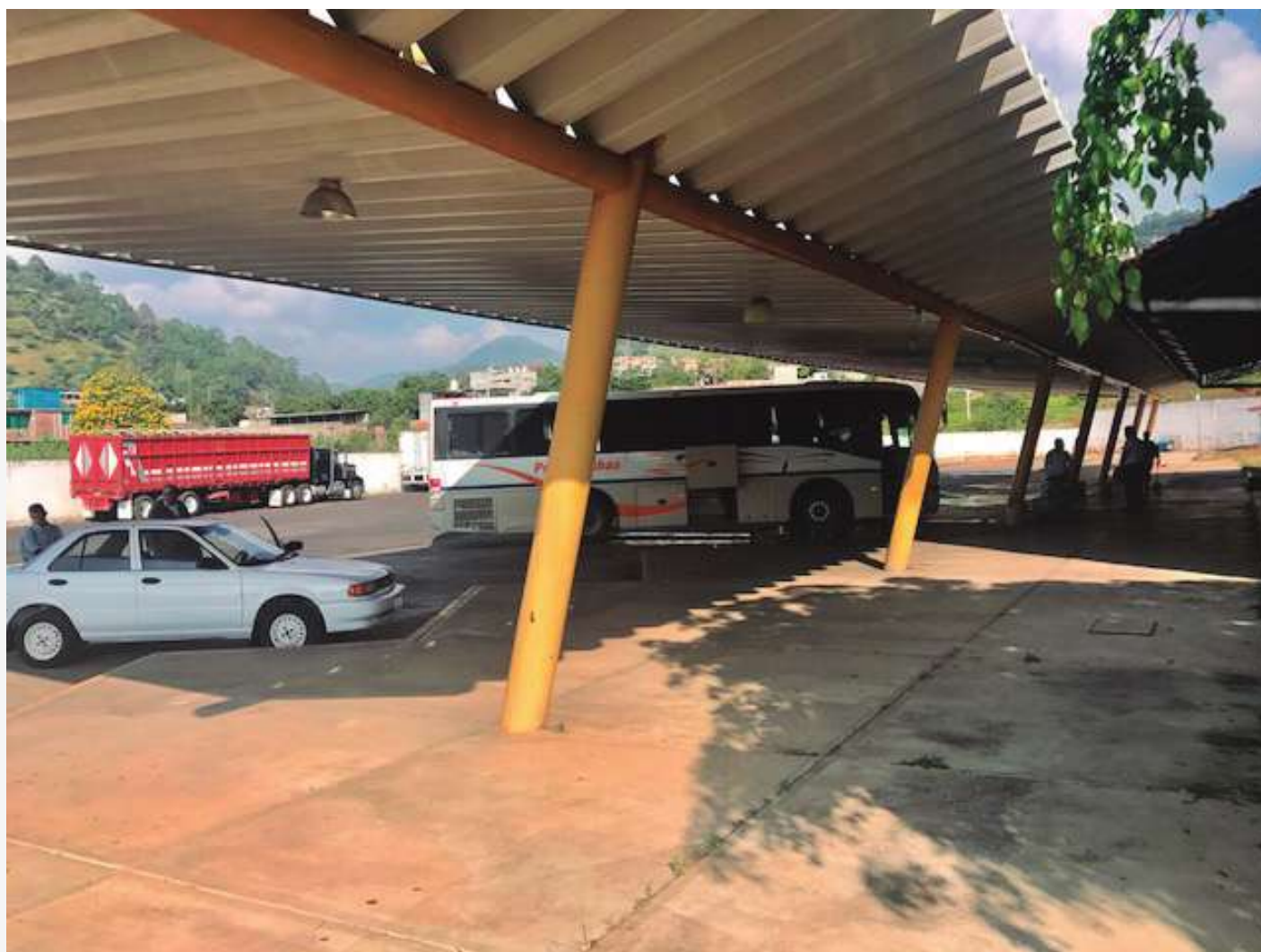
Figura 1. Andén de autobuses con capacidad para 18 autobuses.
