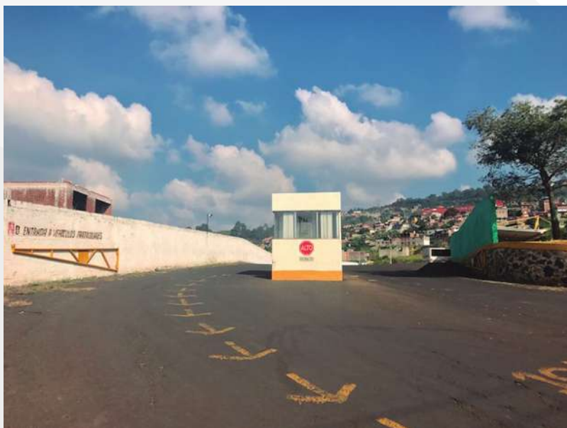
Figura 32. Caseta de control para el acceso y salida de autobuses
