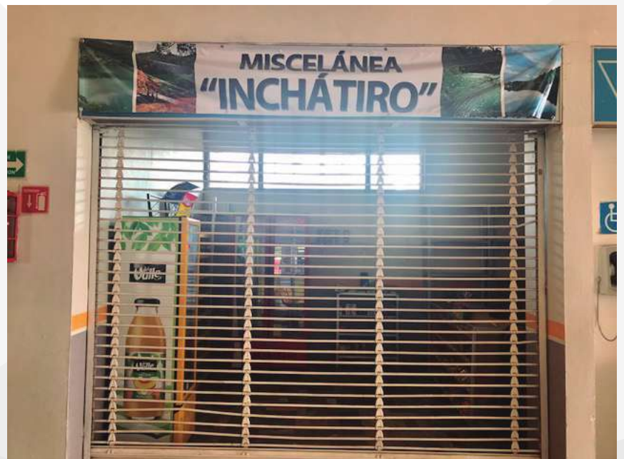
Figura 41. Miscelánea de la Central Camionera, la cual se encuentra cerrada.
