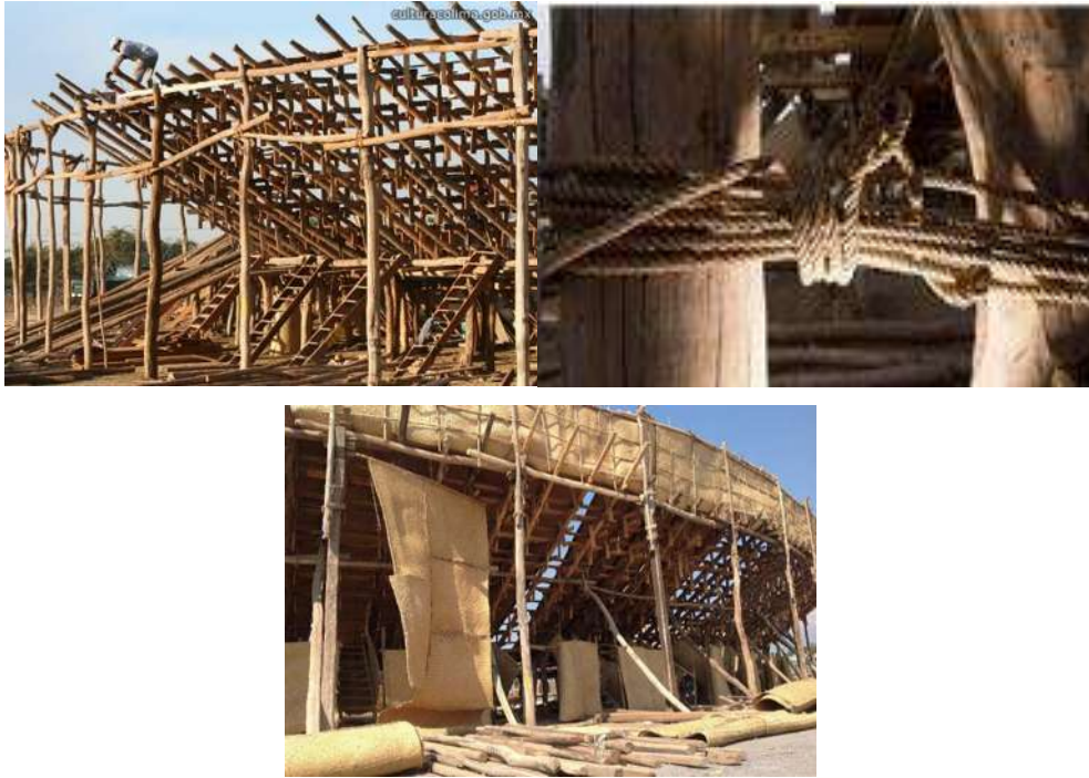
Figura 30. Fotografías de la construcción de “La Petatera”. Fuente: obrasweb.mx
