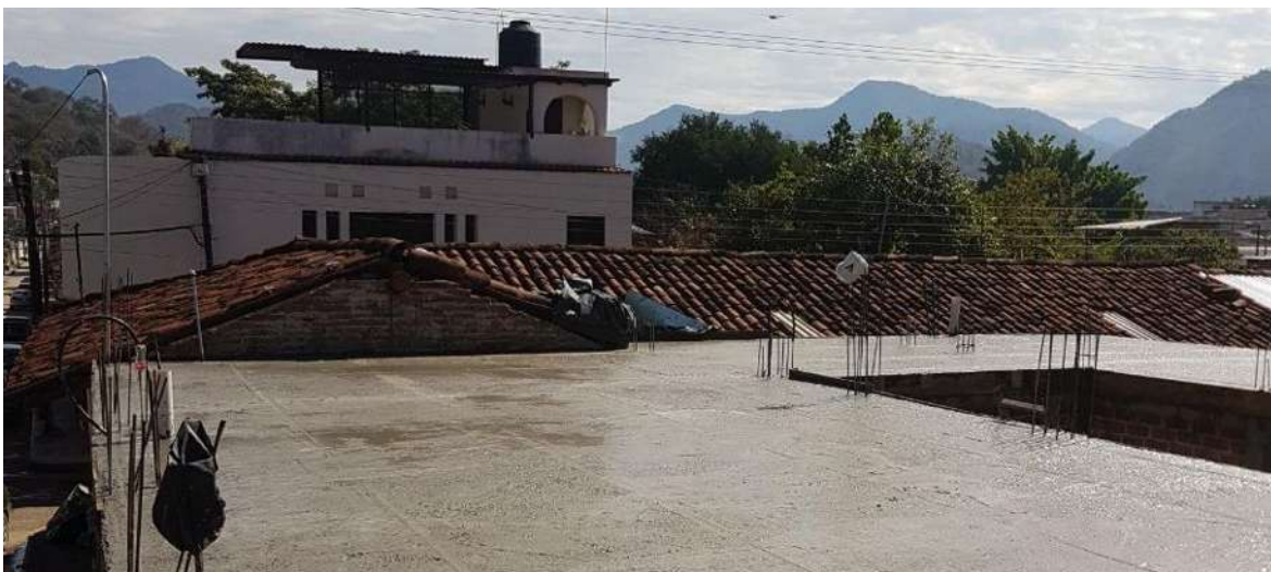
Figura 16. Sustitución de una vivienda a base de barro y Teja por Tabique aplanado y losa de Concreto en el centro de Coalcomán. Fuente: Foto tomada en visita de campo.
