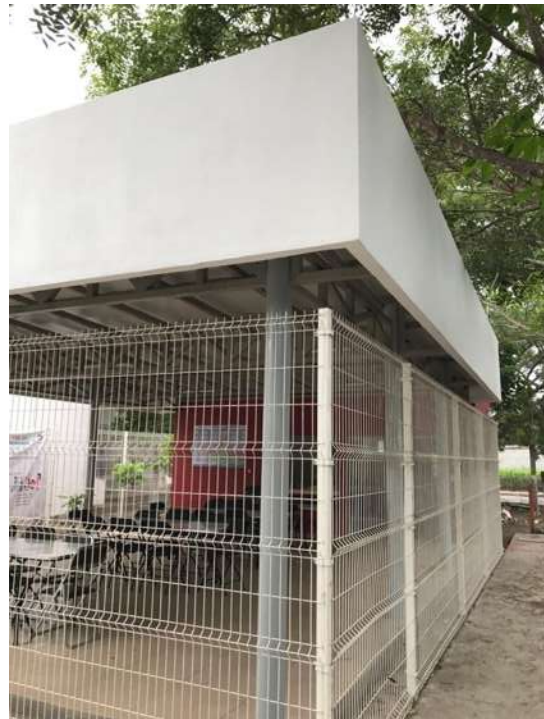
Imagen #43.-Faldones de Durock y reja marca DeACERO, Autor: (JAVAR).
