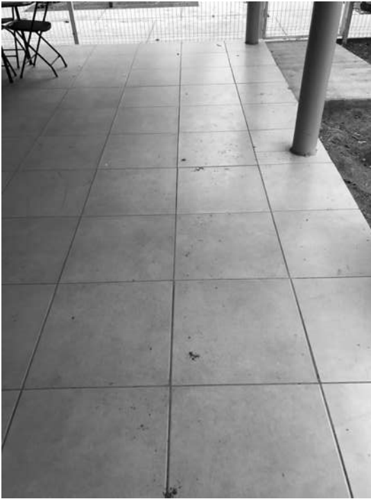
Imagen #42.- Piso de loseta cerámica 0.50x0.50 m Vitromex, Autor (JAVAR).
