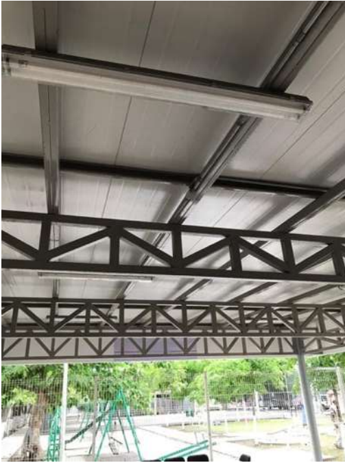
Imagen #31.- Ductería de conduit galvanizado \frac{1}{2} ", Autor: (JAVAR).
