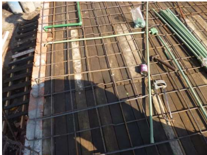
imagen #32.- Ductos de Conduit PVC \frac{1}{2} " tipo pesado, Autor: (JAVAR).
