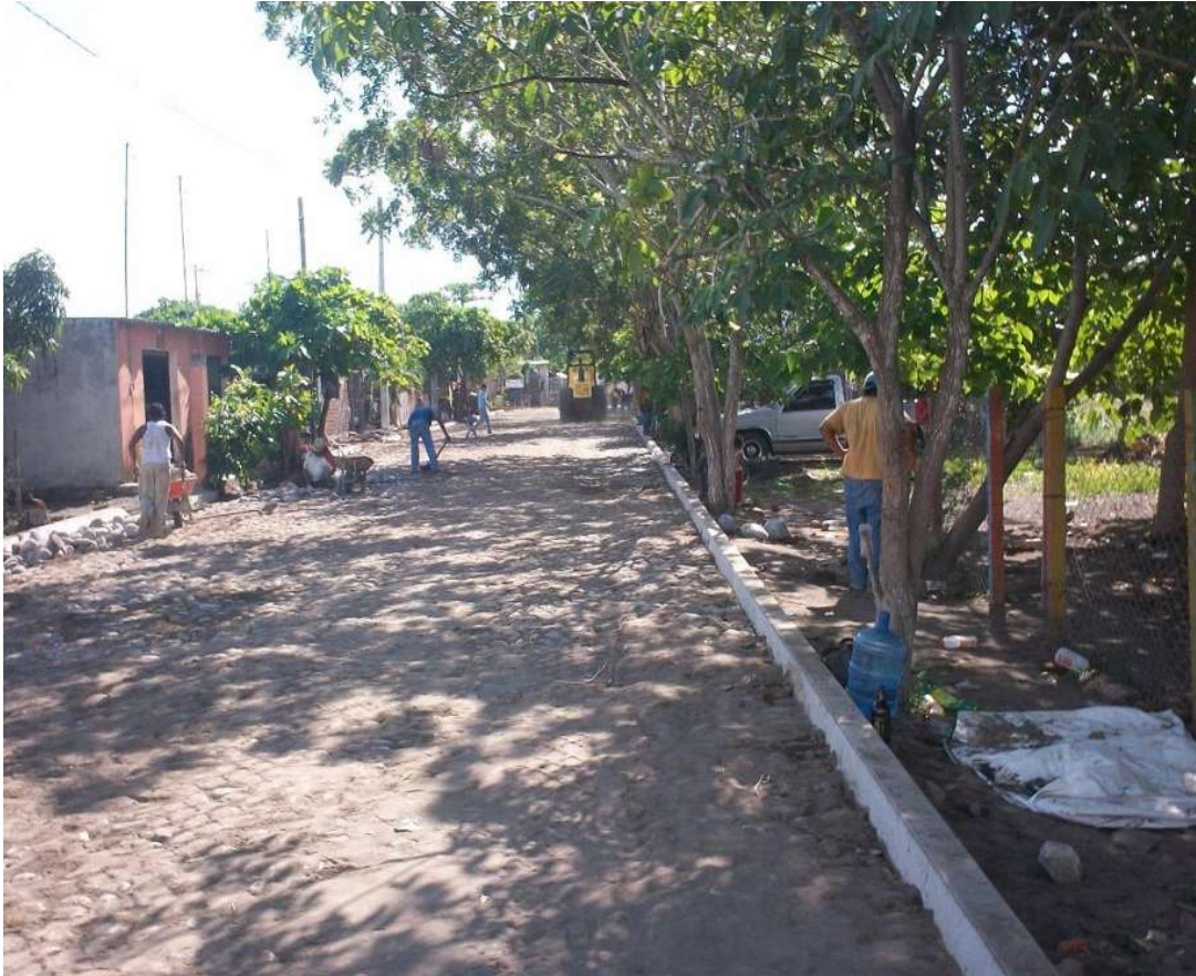
Imagen #10.- Construcción de empedrado asentado en tierra, Autor. Jesús A. Vargas Vargas (JAVAR)
