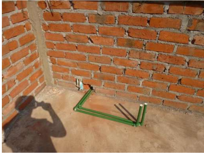
Imagen #33.- Tubería Tuboplus para instalación sanitaria, Autor (JAVAR)
