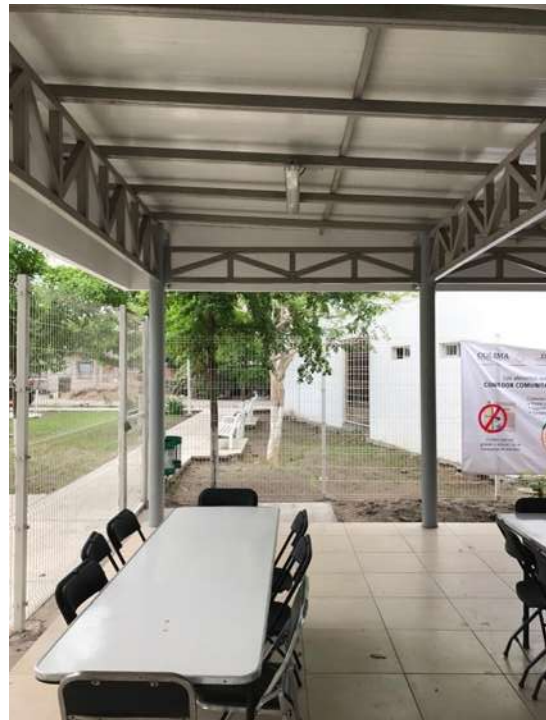
Imagen #41.- Cubierta de lámina Multypanel, Autor: (JAVAR).
