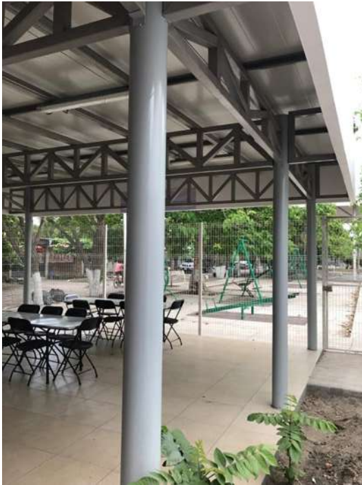
Imagen #27.- Columna de acero 6"Ø cedula 40 autor (JAVAR)
