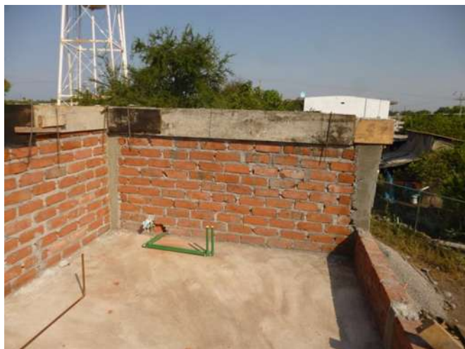
Imagen #35.- Tubería para instalaciones gas e hidráulica, Autor: (JAVAR).
