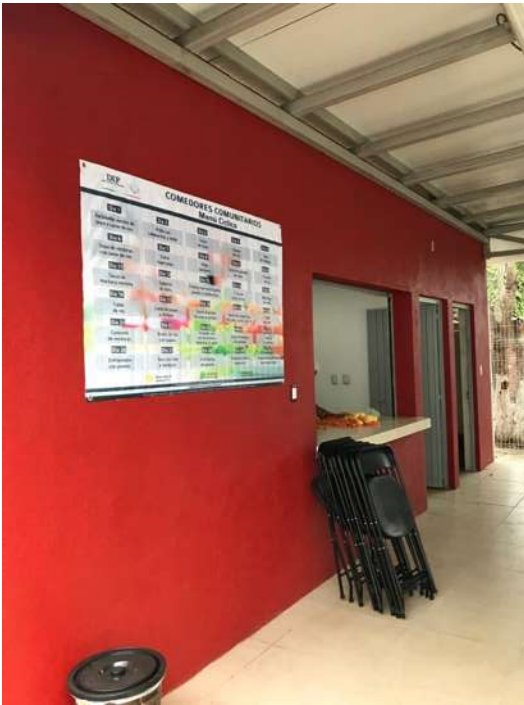
Imagen #40.- Muros aplanados, Autor (JAVAR).
