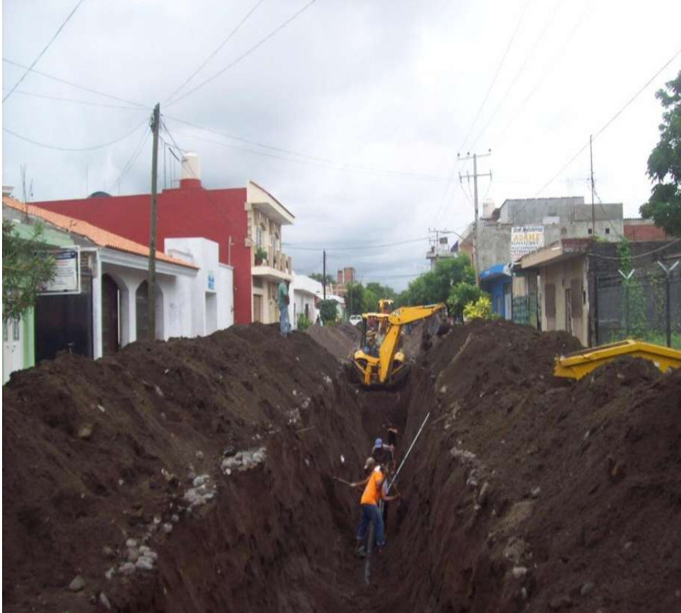
Imagen #8.- Construcción drenaje varias calles Armería, Col. Autor: Jesús A. Vargas Vargas (JAVAR)
