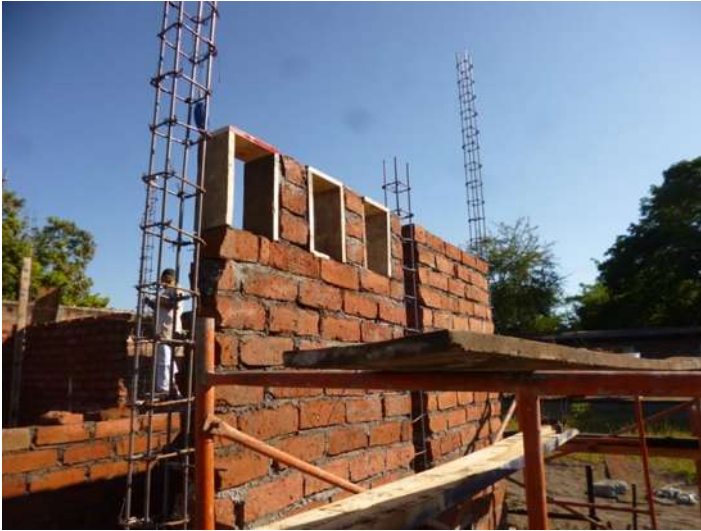
Imagen #29.- Muros de ladrillo rojo recocido, confinados por cadenas y castillos, Autor: (JAVAR).
