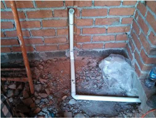
Imagen #36.- salida sanitaria PVC 2", Autor (JAVAR).
