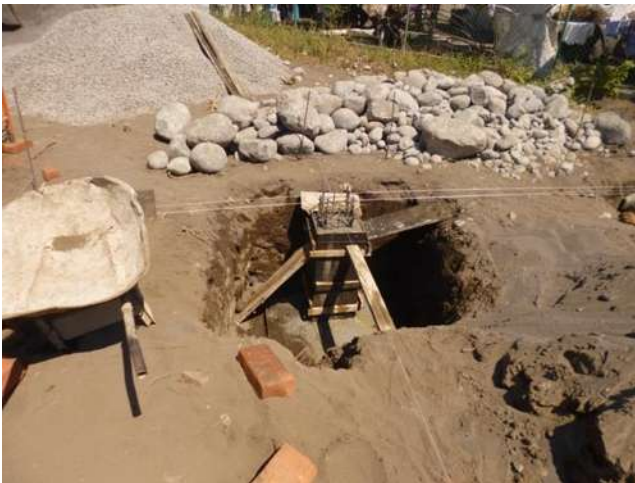
Imagen #22.- Zapata aislada de concreto, Autor: (JAVAR).
