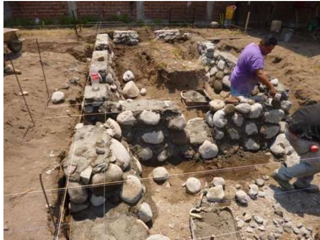
Imagen #21.- Zapata corrida de piedra de la región Autor: (JAVAR)
