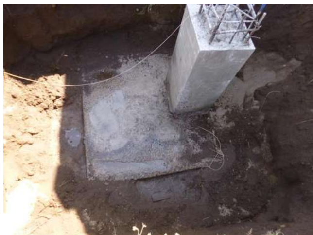
Imagen #23.- Zapata aislada de concreto, Autor: (JAVAR).
