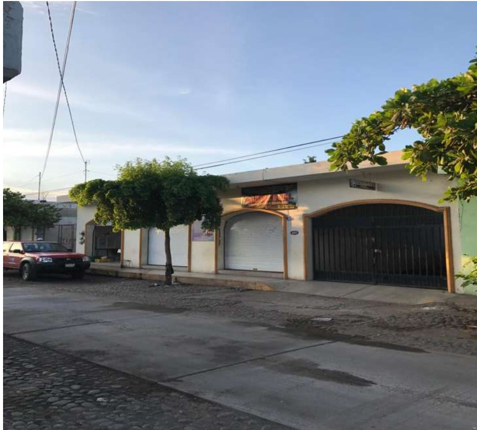
Imagen #7.- Construcción de locales comerciales, col. Centro Armería, Col. Autor: Jesús A. Vargas Vargas (JAVAR)
