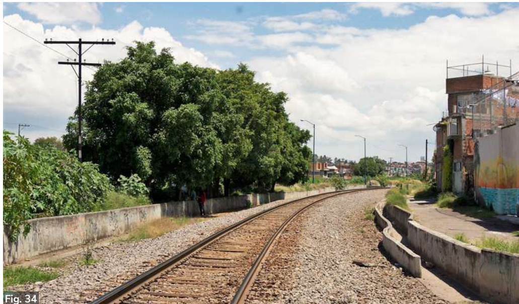
Fig. 34. Muros de contención a los costados de las vías férreas paralelas a la calle Del ferrocarril. Fotografía: CIGF. Fecha: 17/sep/2017.
