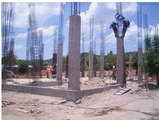
Imagen 32: Cimentación y estructura de concreto
