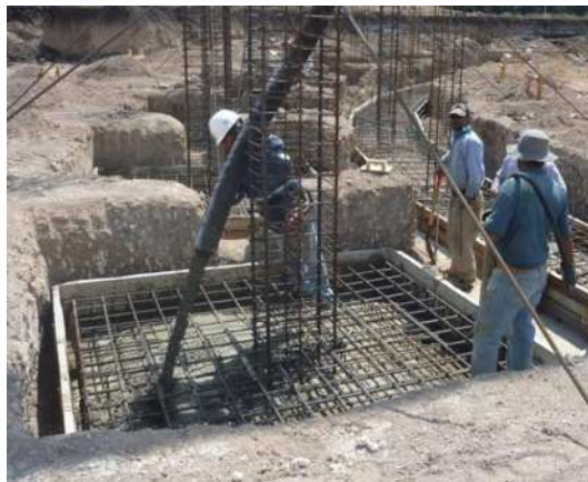
Imagen 28: Zapata aislada de concreto armado Fuente: www.costosperu.com/noticias/excel-zapatas-aisladas-esquinas/
