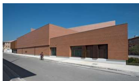
Imagen 53: Fachada posterior Fuente: ArchDaily
