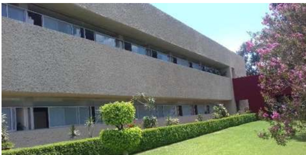
Fig. 27 Ventanas de los Consultorios. Foto: Ivette Trinidad
