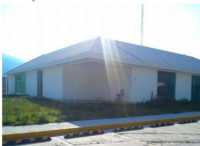
Fig. 9 Fachada Oriente y Sur del área de atención continua. Foto: Ivette Trinidad
