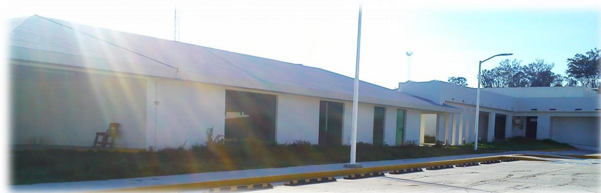
Fig. 2 Fachada Oriente del Área de CEyE y rampa hacia el área de Almacén. Foto: Ivette Trinidad
