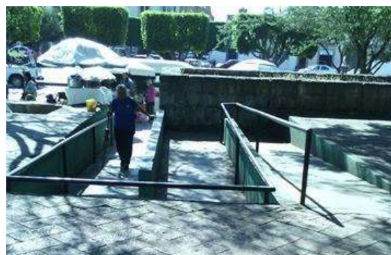
Fig. 34 Rampa para discapacitados. Foto: Ivette Trinidad
