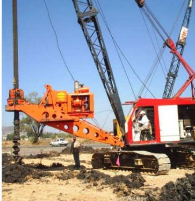
**Figura 50.** Perforación de inclusiones de cimentación Conjunto Habitacional Campestre del Vergel, Morelia. **Fuente:** Pilotec (2006).
