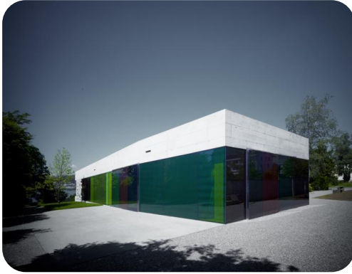
Ilustración 11 Edificio del cementerio en Erlenbach. Fuente: http://www.metalocus.es/content/es/blog/edificio-del-cementerio-en-erlenbach .
