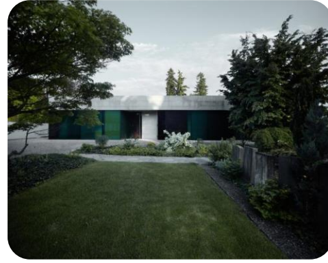
Ilustración 12 Edificio del cementerio en Erlenbach. Fuente: http://www.metalocus.es/content/es/blog/edificio-del-cementerio-en-erlenbach .
