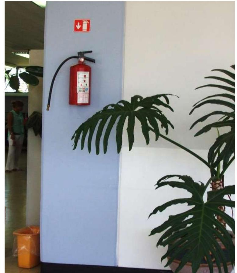
*Foto (54). Extinguidor con Señalamiento Propio.
