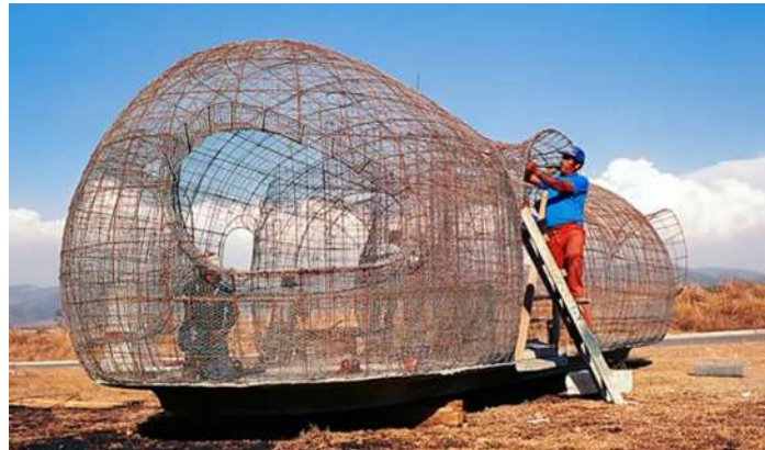
12.- Se muestra el armado de acero de las membranas.
