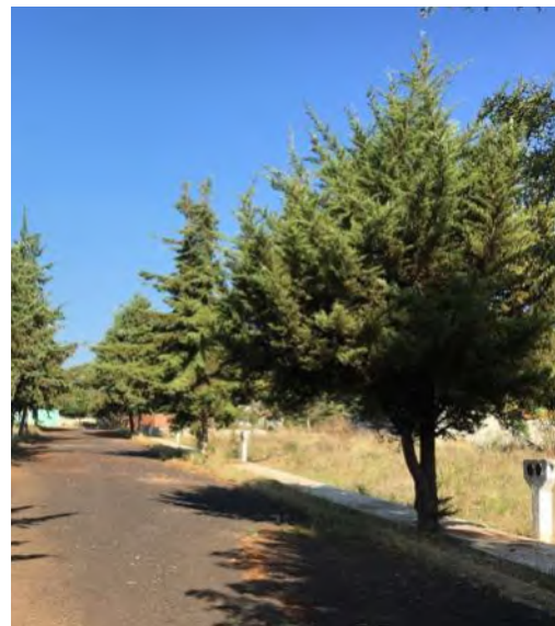
Foto 5.4 Medidores de electricidad en los lotes. JPGP.
