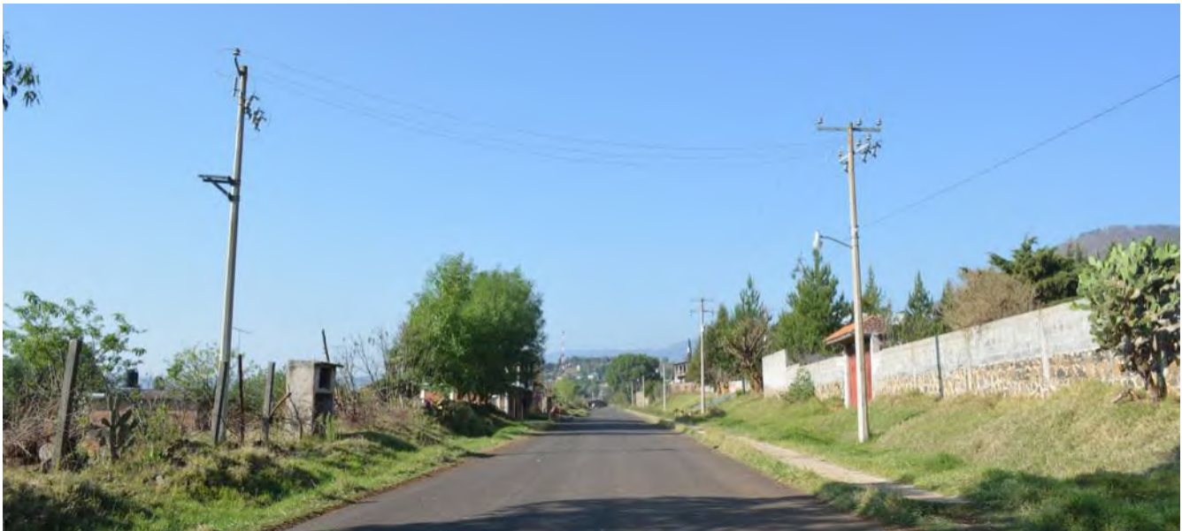
Fotografía 5.3 Vialidad Isidro Huacuz, líneas eléctricas de media tensión se distribuyen cerca del predio. Fuente: JPGP.
