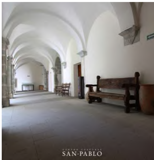
Foto. 2. 7 Pasillo y su bóveda de crucería Fuente: CCSP.
