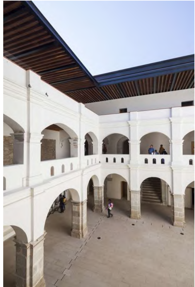
Foto 6.8 El gran atrio principal, cuya cubierta es móvil para controlar el clima mediante su sombra. Fotografía: www.archdaily.mx
