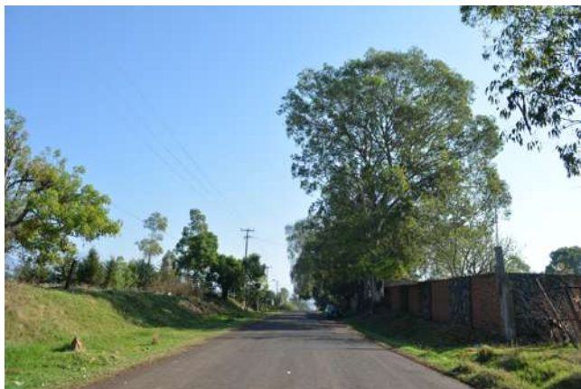
Fotografía 5.6 Calle Isidro Huacuz en buen estado de conservación.
