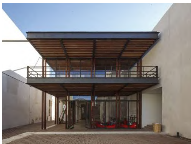
Foto 2.8 y 2.9 Arriba: Galería de exposiciones y escaleras que llevan a la cafetería. Al fondo, sala de lectura. Abajo: patio y sala de lectura.
