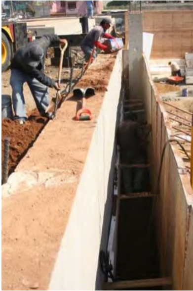
Ilustración V' Fotografía propiedad de Mauricio Rocha, Escuela de Artes Plásticas en Oaxaca. Se muestra la manera de rellenar en el encofrado.
