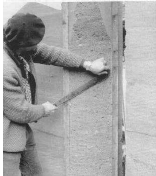
Ilustración X' Gernot, op, cit, p.64. Tapial cortado directamente después de quitar el encofrado.
