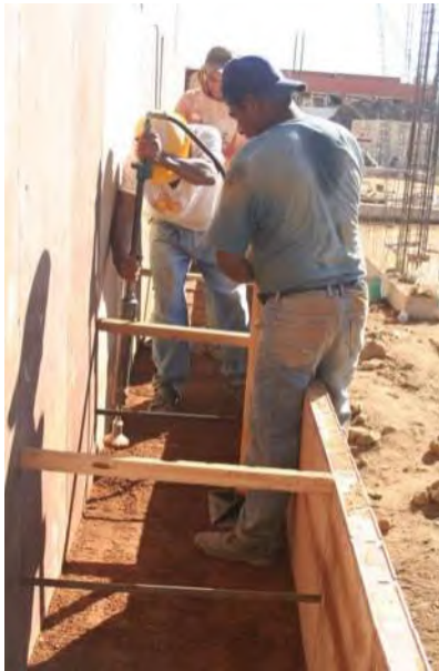
Ilustración W' Fotografía propiedad de Mauricio Rocha, Escuela de Artes Plásticas en Oaxaca. Se muestra el compactamiento de la tierra
