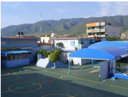
Imagen 6 Vista aérea del Patio del Colegio CECH. Autor: Maurilio Hipólito Olivares. 10/12/2015.
