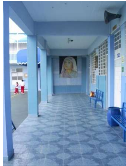
Imagen 2 Interior de uno de los pasillos del Colegio. Autor: Maurilio Hipólito Olivares. Fecha: 10/12/2015.
