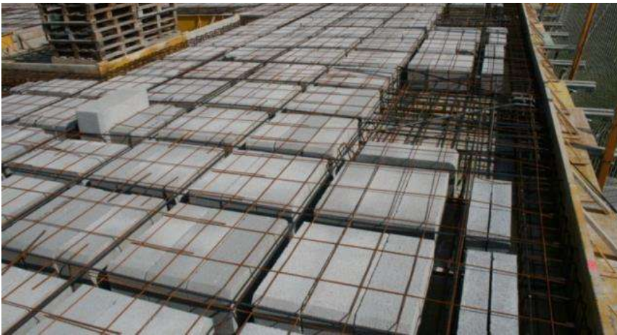
Imagen 15.- Losa Reticular o de Nervaduras (ARMADO)
