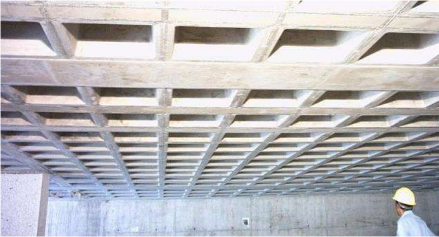
Imagen 16.- Losa Reticular o de Nervaduras (ACABADOS)
