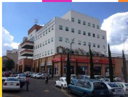
Ilustración D Edificio Inegi vista en la calle Valentín Gómez Farías. Fuente: elaboración propia @dcrizzdje
