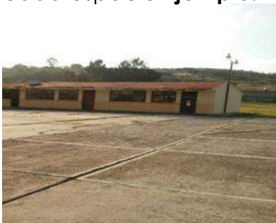
fig.1 Vista principal de la escuela,
