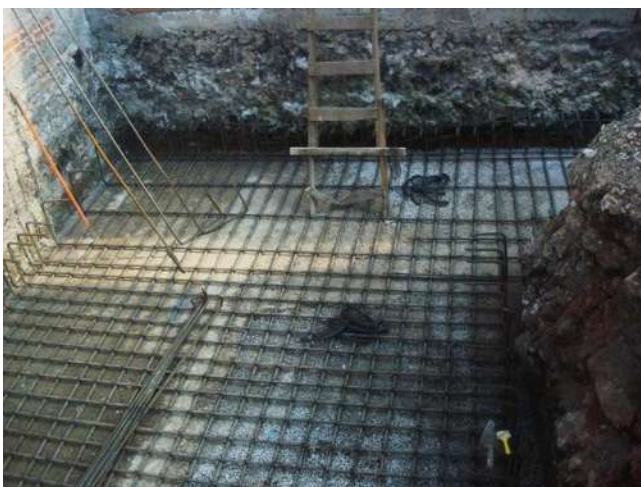
Imagen 51. Acero en cimentación, cortesía del autor.
