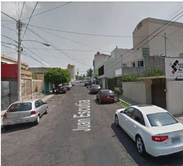
Imagen 16, arbotante y cableado aéreo, Google maps.
