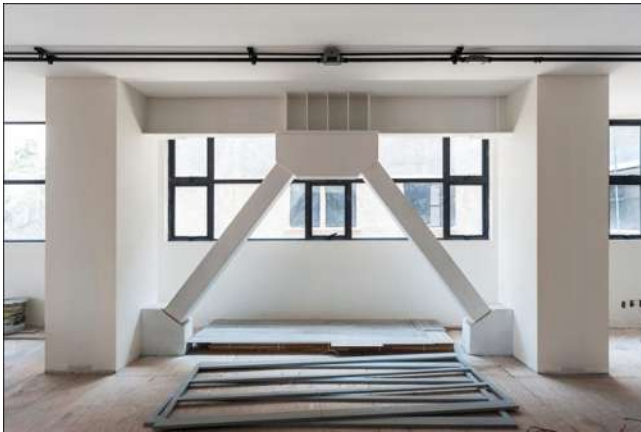
Imagen 33. Marco de refuerzo interior, cortesía de JSa en https://archdaily.mx
