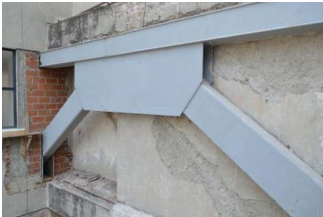
Imagen 31. Refuerzo estructural, cortesía de JSa en https://archdaily.mx
