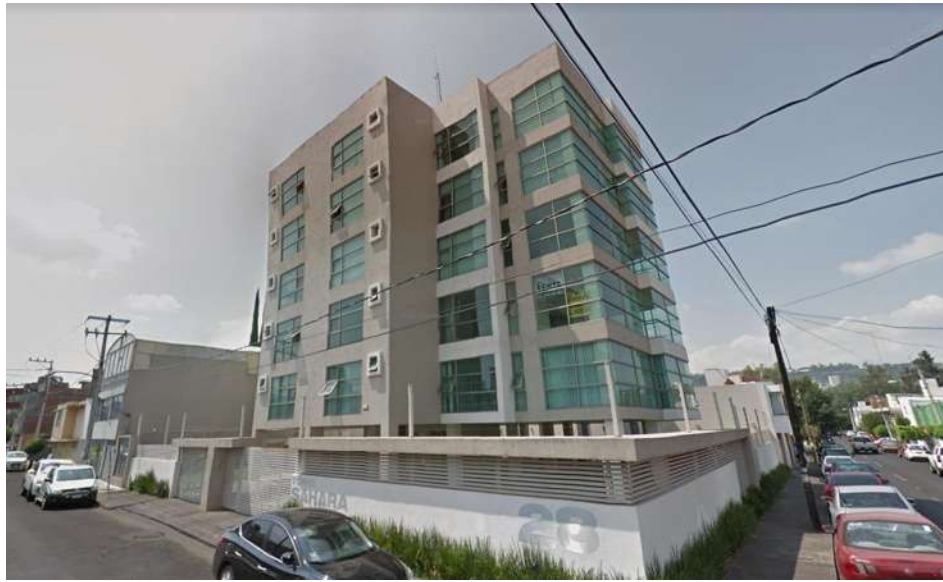
Imagen 6. Edificio habitacional de seis niveles, Google maps.
