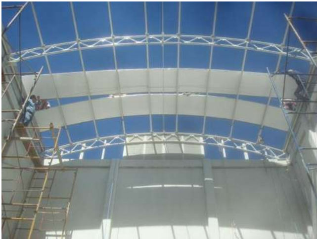
Imagen 66. Estructura para cubierta, cortesía del autor.
