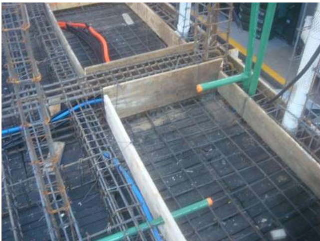
Imagen 57. Instalación hidráulica, cortesía del autor.
