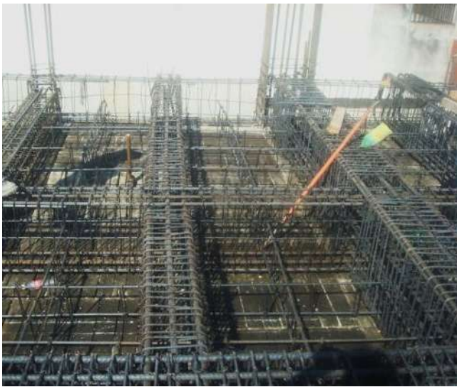
Imagen 50. Acero en losa, cortesía del autor.
