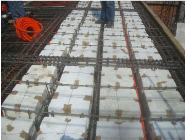
Imagen 62. Losa reticular, cortesía del autor.
