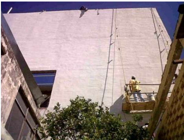
Imagen 65. Aplanado exterior, cortesía del autor.
