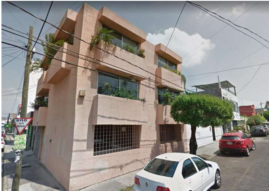
Imagen 7. Edificio de oficinas de tres niveles, Google maps.
