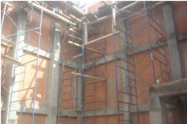
Imagen 64. Tendido con andamios, cortesía del autor.
