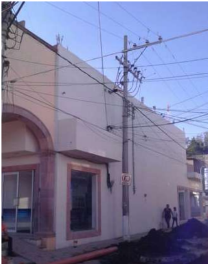
Imagen 37. Fachada lateral estado actual, cortesía del autor.
