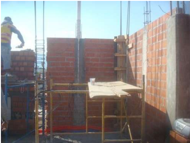
Imagen 52. Muros de tabique, cortesía del autor.
