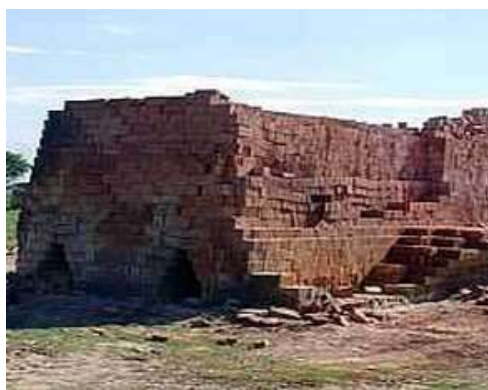
Imagen No 13. Fotografía tomada por Luis Alberto Becerra, en esta imagen se aprecia una de las tabiqueras de Jesús del Monte.
