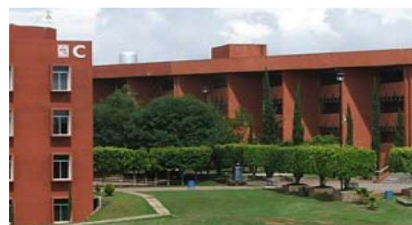
Imagen No 24.- Imagen del Autor, Fachada de la Universidad UVAQ
