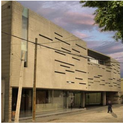
FIGURA 68. Fachada frontal del edificio "Vaducto115". FuenteArchdaily.com
