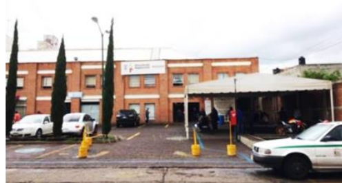
FIGURA 02. Fachada principal del actual edificio de la dirección de registro civil de Michoacán. Fotografía tomada por el autor.
