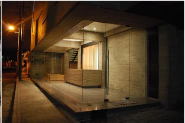
FIGURA 69. Fachada frontal del edificio "Vaducto 115". FuenteArchdaily.com
