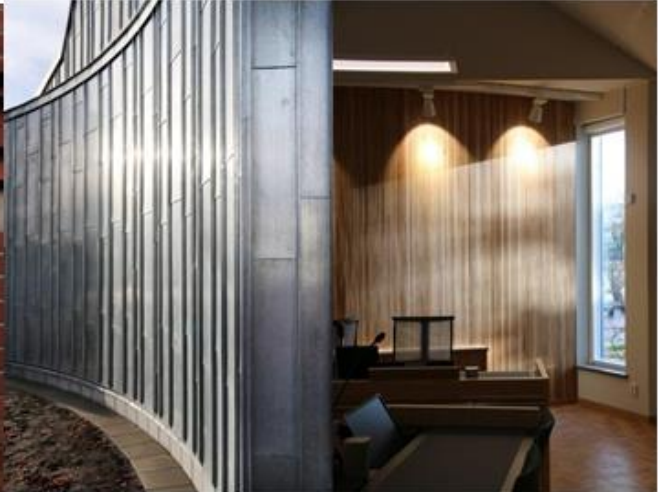
FIGURA 87. Detalle del material Zinc al exterior del edificio. Fuente Archdaily.com
