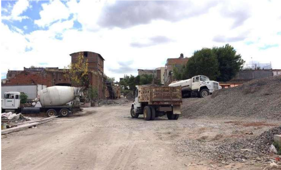
Figura 100. Imagen del terreno, se muestra alguna maquinaria de construcción y material para la misma, ya que dicho terreno está siendo utilizado como lugar de almacén de los constructores, únicamente para la obra de mejoramiento de pavimento de la Av. Héroes de Nocupétaro, dicha obra será finalizada a finales del mes de febrero del 2018, y con ello, el predio será desocupado. Fotografía por el autor.
