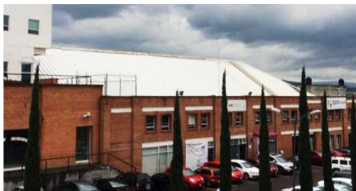
FIGURA 01. Imagen del actual edificio de la dirección de registro civil que muestra la cubierta de lámina a dos aguas. Fotografía tomada por el autor.
