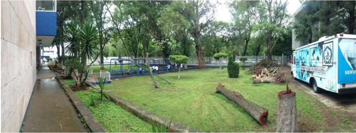
Fig 19: Fotografía de las condiciones actuales de las instalaciones de la facultad de odontología de la UMSNH acceso al edificio (foto 2), Fuente: JMCG,2018
