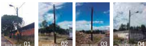
FOTOGRAFÍAS TOMADAS POR EL AUTOR. POSTES DE LUZ, APOSTOL DE LA RAZA MAYA FELIPE CARRILLO PUERTO MORELIA, MICHOACÁN.
