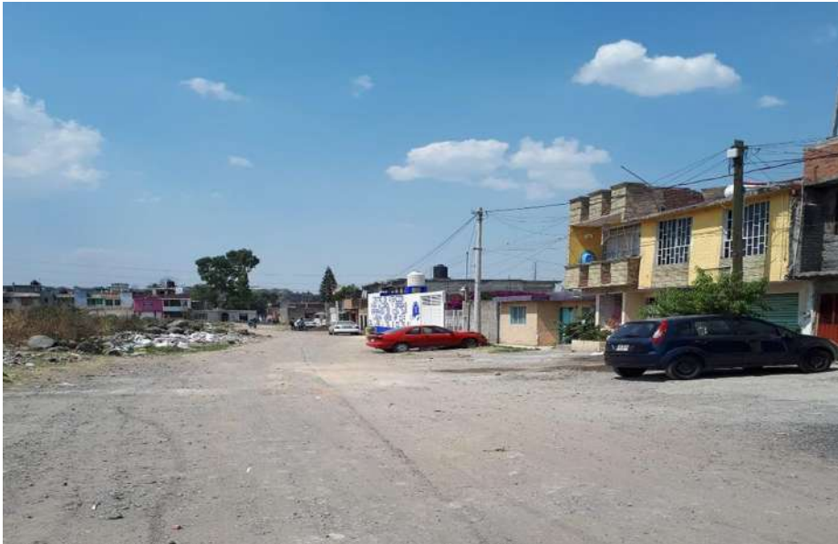
Ilustración4 alcantarillado el sitio, fuente: propia
