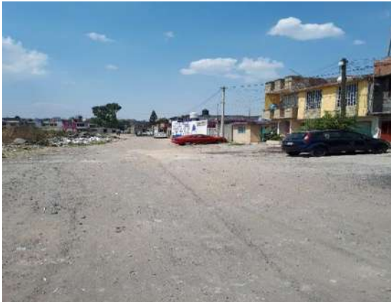
Ilustración3 postes de luz en el sitio, fuente: propia[24/11/16]
