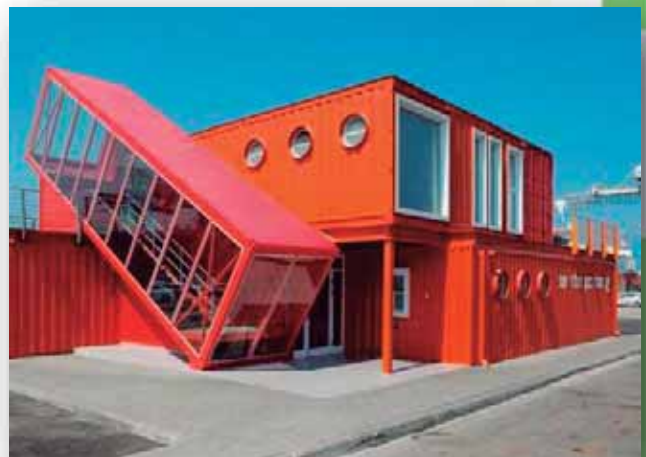
Imágen obtenida de la página web http://www.gradnja.rs/stepeniste-zgrade-od-transportnog-kontejnera/
