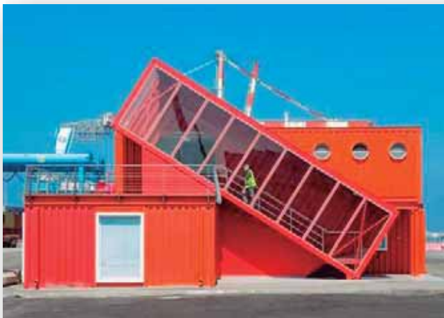
Imágen obtenida de la página web http://www.gradnja.rs/stepeniste-zgrade-od-transportnog-kontejnera/
