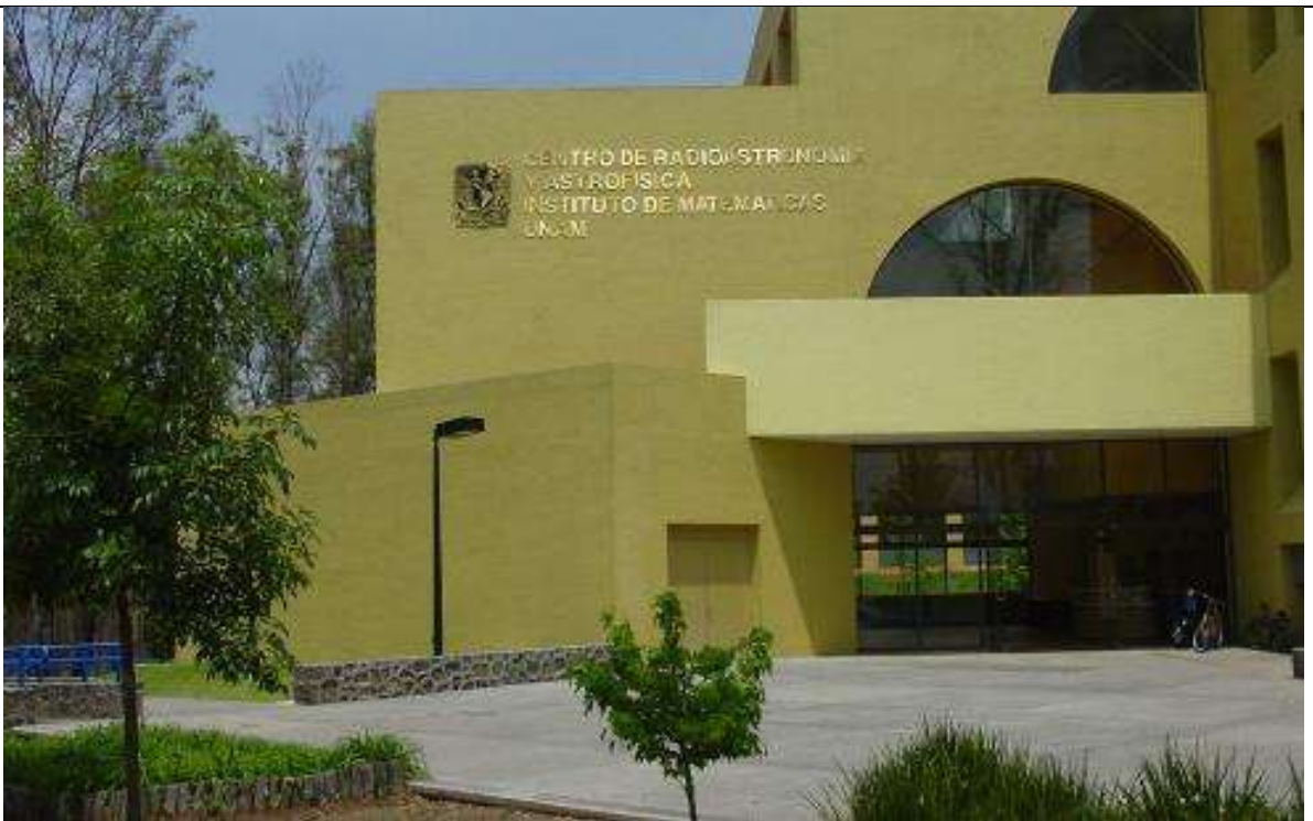
Fachada Principal de Centro de Radioastronomía y Astrofísica, UNAM, Campus Morelia
