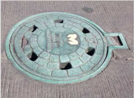
Imagen 4.13 Servicio de drenaje FUENTE: Autoria propia
