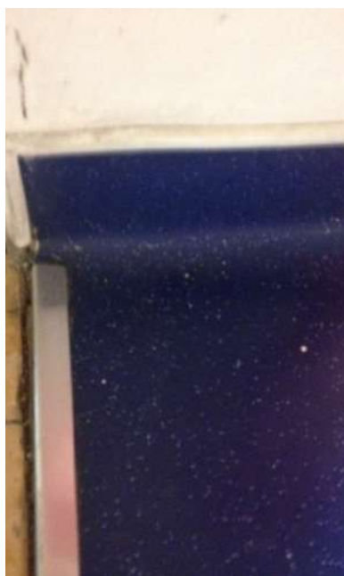
Imagen 1.44 Pisos de vinil, evitando esquinas FUENTE: Autoria propia
