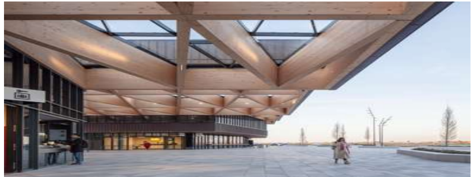
Imagen 1.6 Detalle de cubierta
