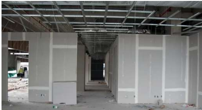
Imagen 6.4 Muros de tabla roca
