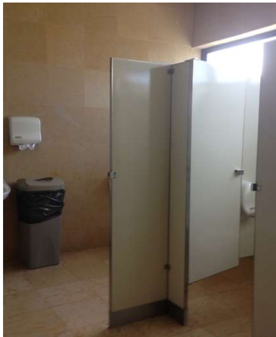
Imagen 1.40 Sanitarios para minusválidos FUENTE: Autoría propia
