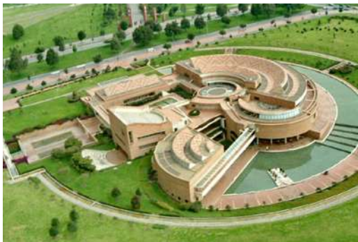
Imagen 1.1 Vista aérea de la biblioteca Virgilio Barco
