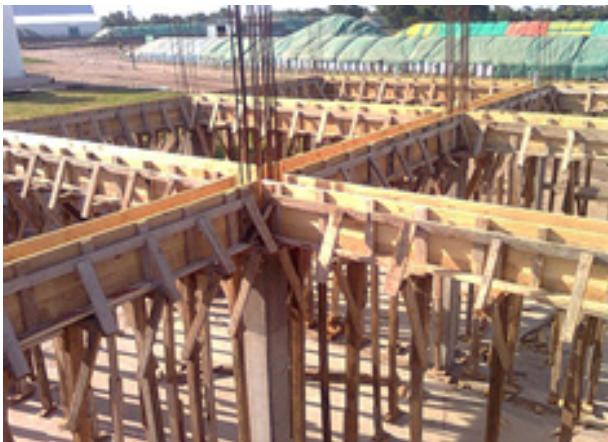
Imagen 6.3 Estructura a base de columnas y traveses de concreto
