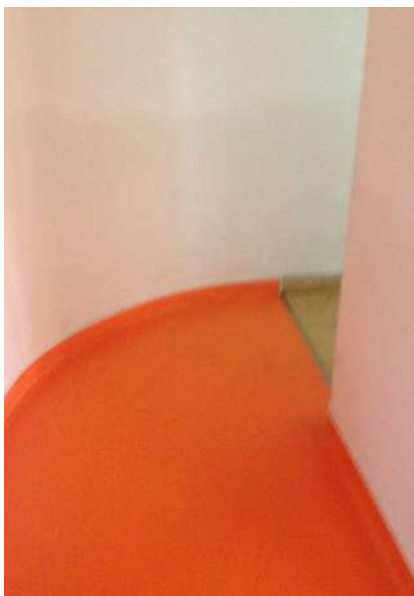
Imagen 1.41 Entrada a sanitarios FUENTE: Autoria propia
