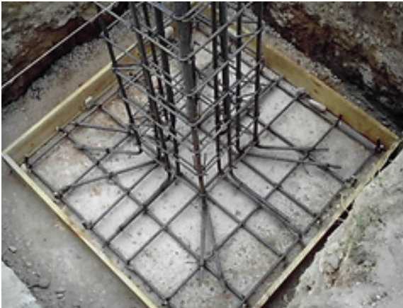
Imagen 6.1 Zapata aislada
