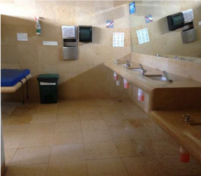
Imagen 1.37 Módulo de sanitarios FUENTE: Autoría propia
