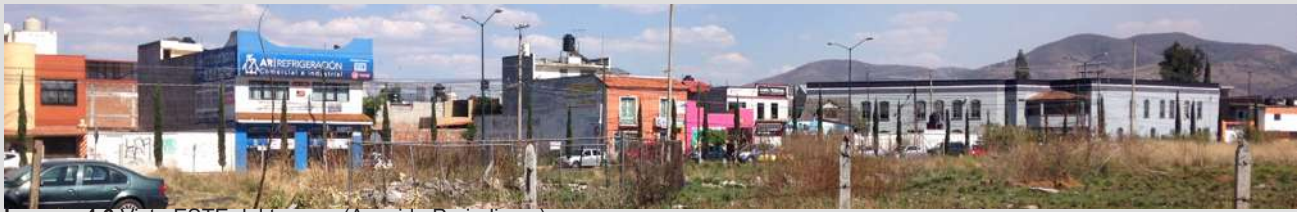
Imagen 4.6 Vista ESTE del terreno (Avenida Periodismo) FUENTE: Autoría propia
