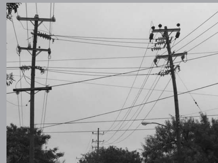
Imagen 29. Alumbrado público. Fuente: Google Imágenes
