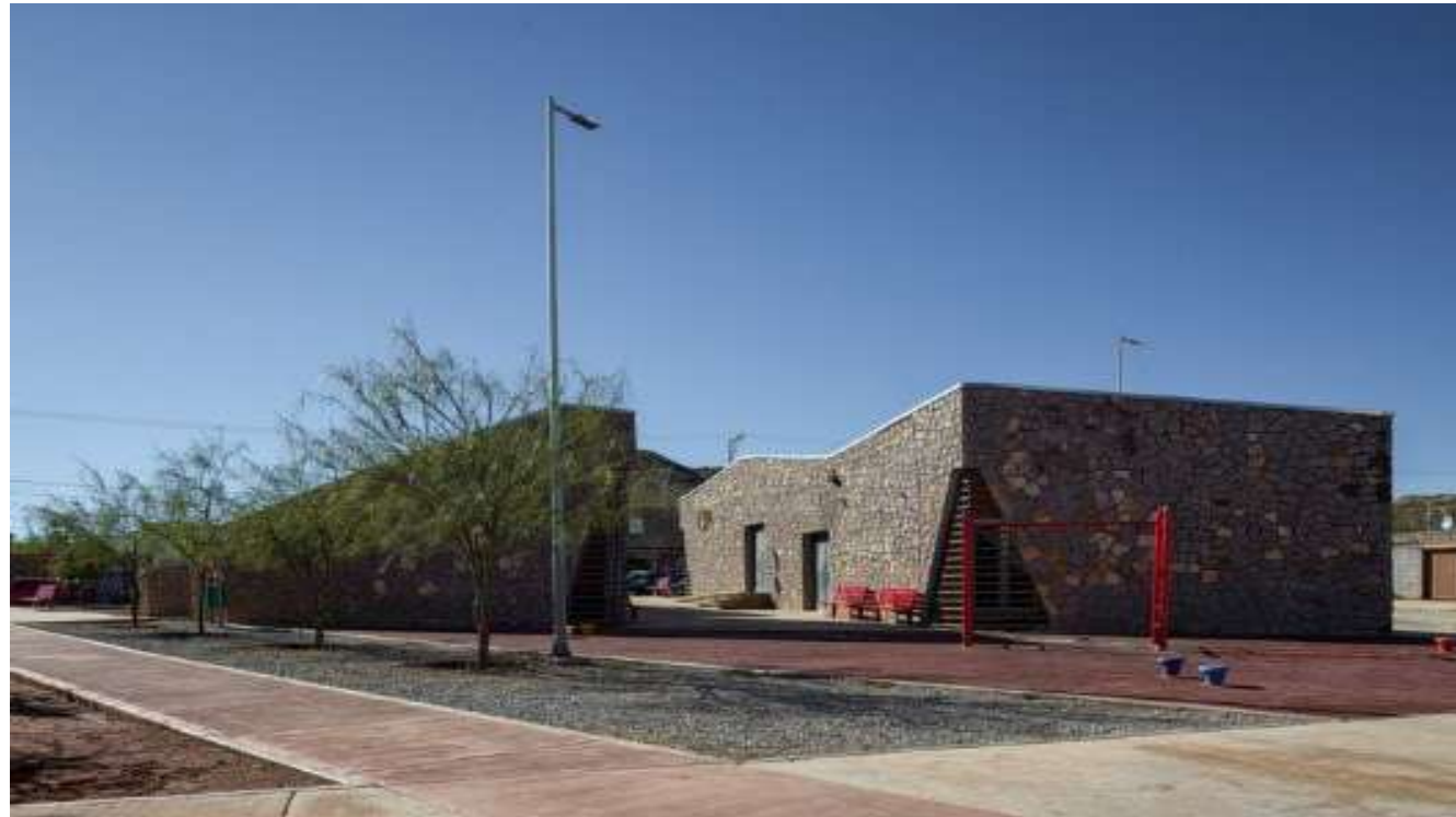
Imagen 35. Fachadas de los diversos espacios. Autor: A. en Proceso
