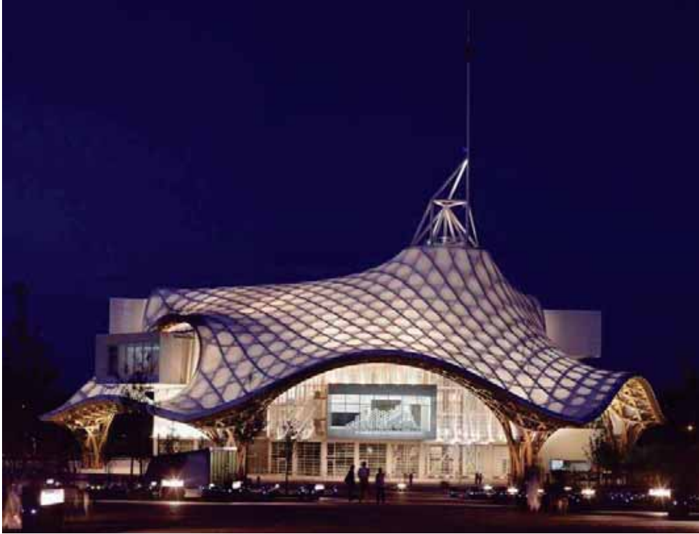
Imagen 28. Galería de Centro, Pompidou Metz, Shigeru Van
