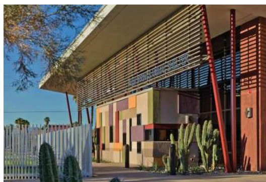
Fig. 40 Fachada lateral norte
