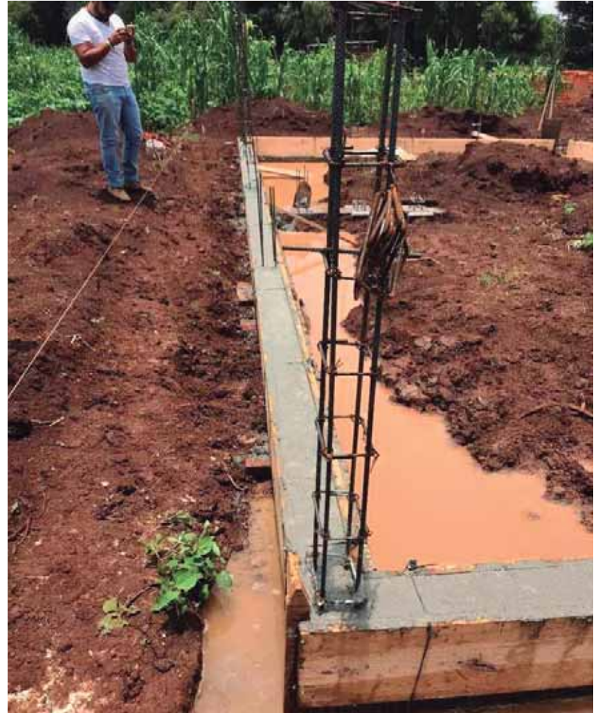
Figura 32. Zapatas corridas, tomada por Mauricio Hernández Trujillo, 10 de Julio del 2018.
