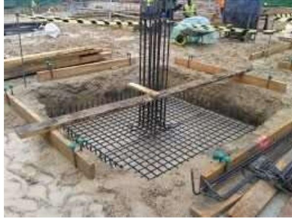
*Ilustración 64. Ejemplo representativo de la construcción de una zapata aislada. Fuente: Pinterest.*
