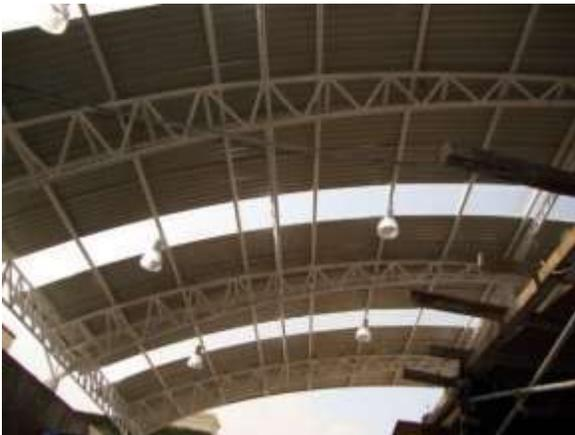
Ilustración 66. Ejemplo de una armadura tipo Pratt, fuente: Pinterest.
