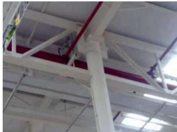
Ilustración 67. Ejemplo de una columna metálica redonda, soldada y atornillada a vigas, también metálicas, fuente: Pinterest
