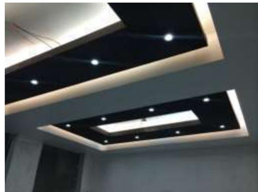
*Ilustración 76. Falso plafón reticulado de lámina esmaltada, fuente: Pinterest.*
