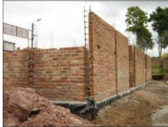
*Ilustración 68. Ejemplo de un muro de tabique rojo recocido, proceso de obra, fuente: Pinterest*
