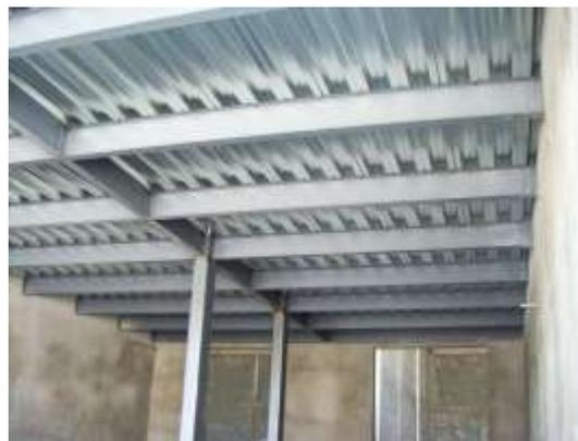
*Ilustración 65. Ejemplo de una lámina acanalada marca Losacero como sistema de entrepiso, fuente: Pinterest*
