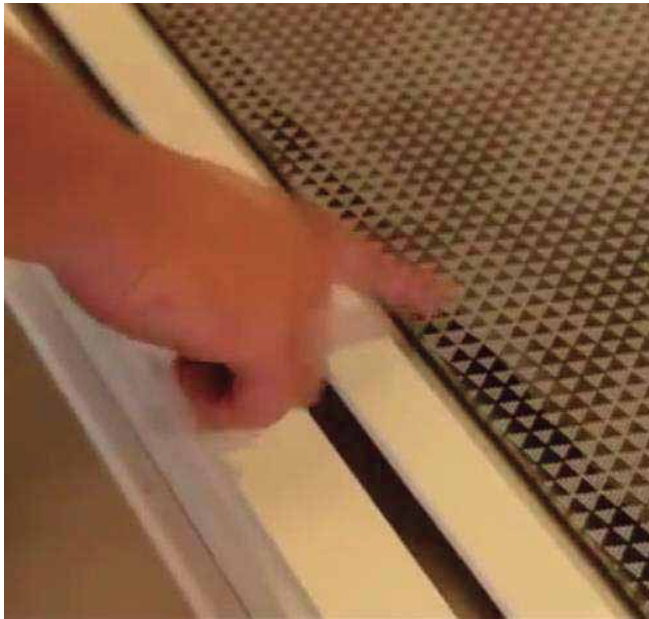
Ilustración 55. Ilustración de la junta generada con la colocación del material en el bastidor que posteriormente se atornilla directo al entramado generado por los OC de 6". Obtenida de https://www.youtube.com/watch?v=UgePsdpKtco . 19/06/18.
