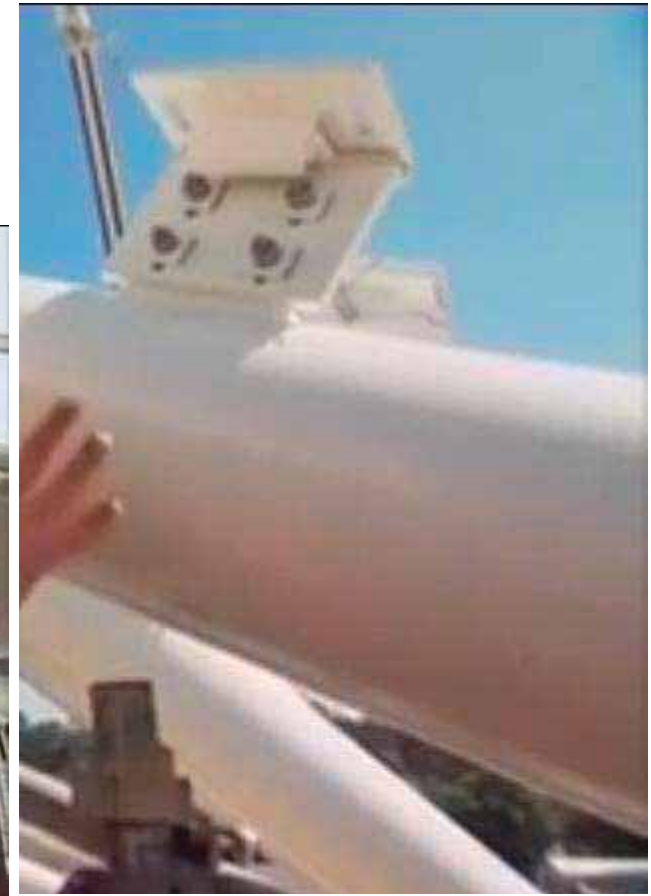
Ilustración 58. Ejemplo del monten soldado sobre el perfil OC de 6” que recibe el bastidor en el cual están montadas las placas de los diferentes materiales. Obtenida de: https://www.youtube.com/watch?v=UgePsdpKtco . 19/06/18
