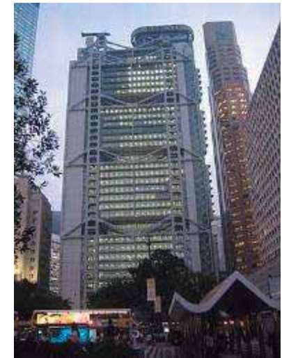
Ilustración 7. La Sede central del HSBC (Hong Kong) de Norman Foster, es un ejemplo de arquitectura High Tech. 17/06/18. https://es.wikipedia.org/wiki/Arquitectura_high-tech
