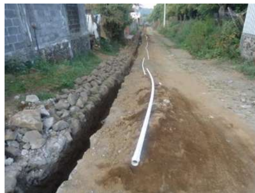
Imagen 21. Instalación de red hidráulica en Tancítaro
